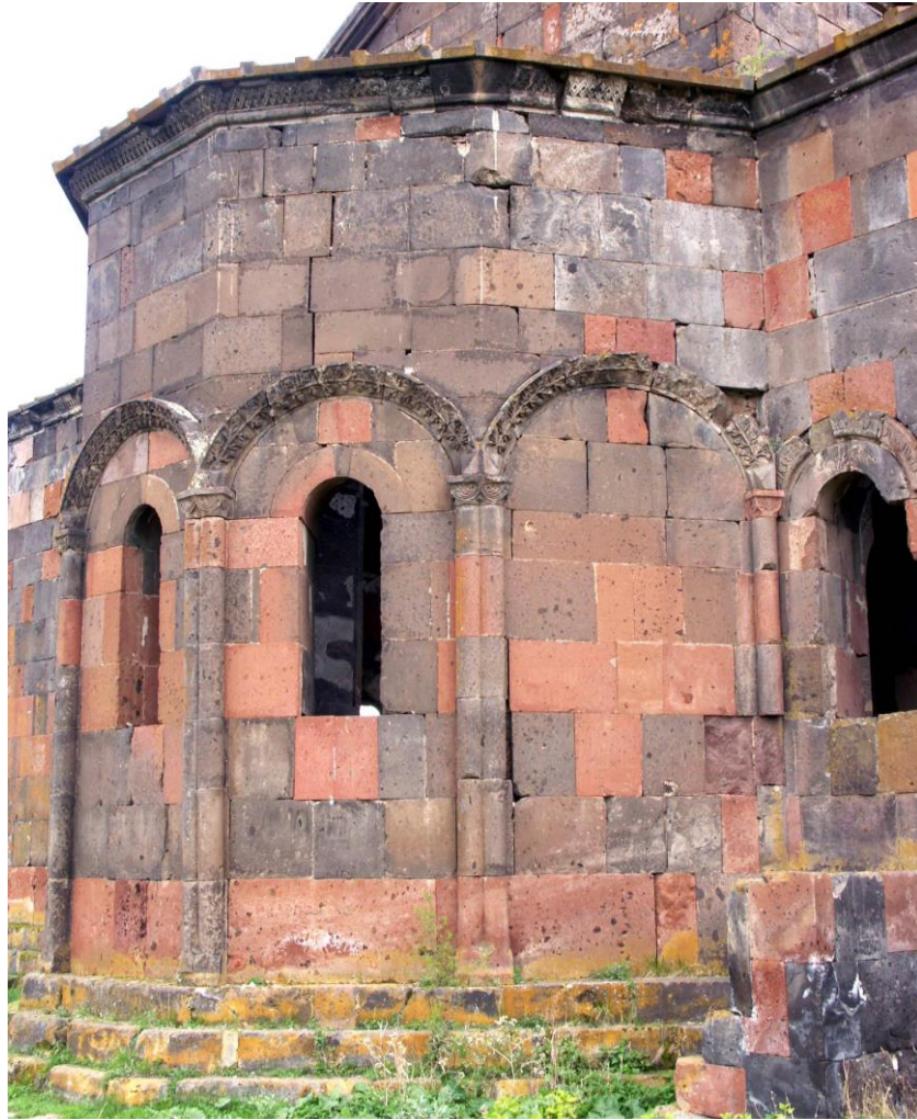
Fig. 9. T'alin, cathédrale, vue extérieure de l'abside nord.
