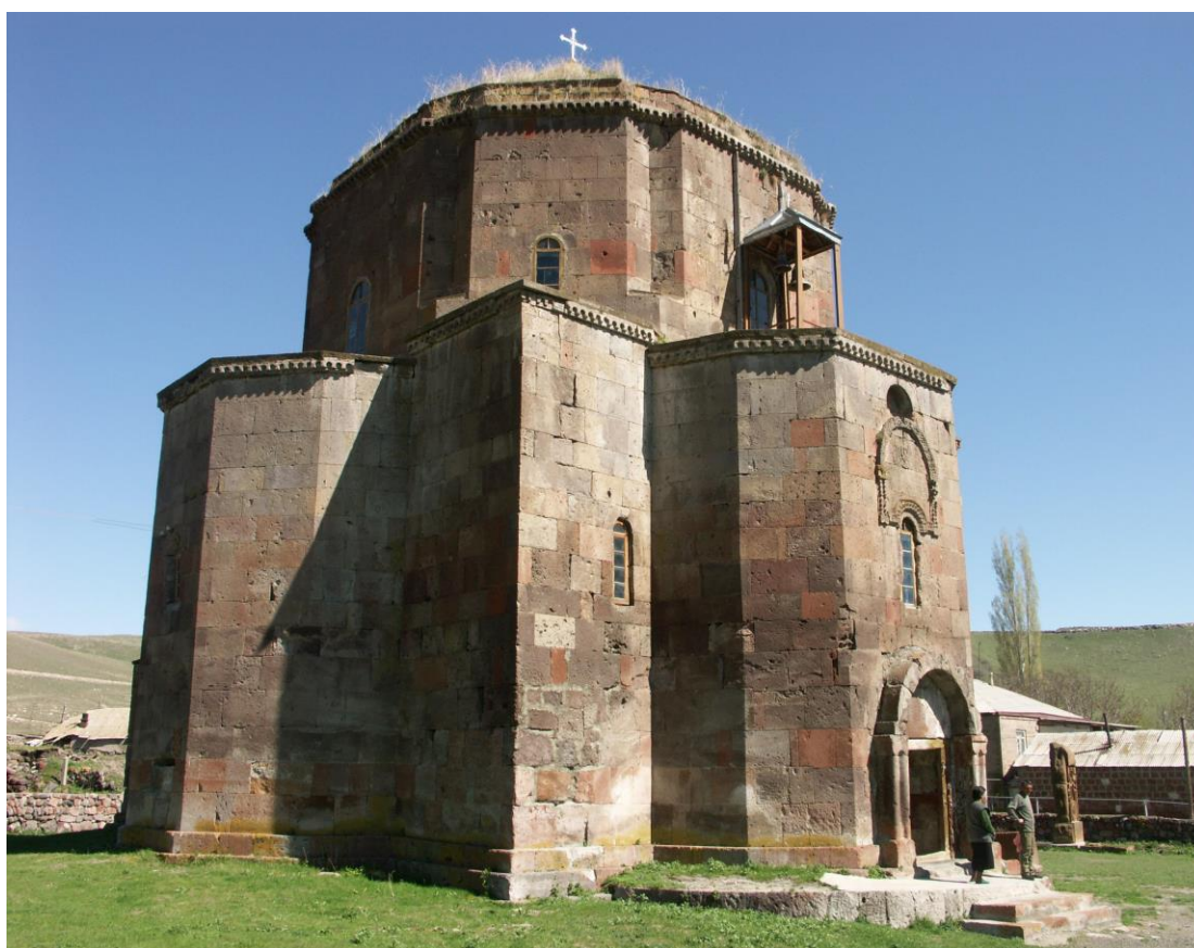
Fig. 17. Mastara, église Saint-Jean, vue du nord-ouest.
