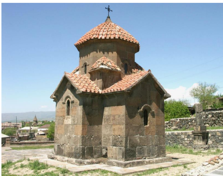
Fig. 13. Aštarak, chapelle, vue du sud-est.
