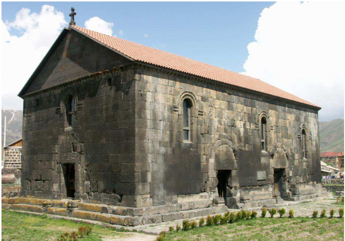
Fig. 14. K'asał, basilique Sainte-Croix, vue extérieure (sud-ouest).
