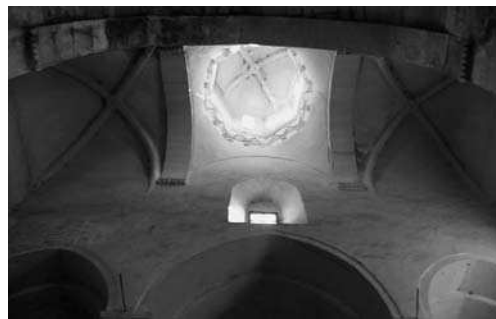
Fig. 12c. Intérieur, coupole et couverture du transept
