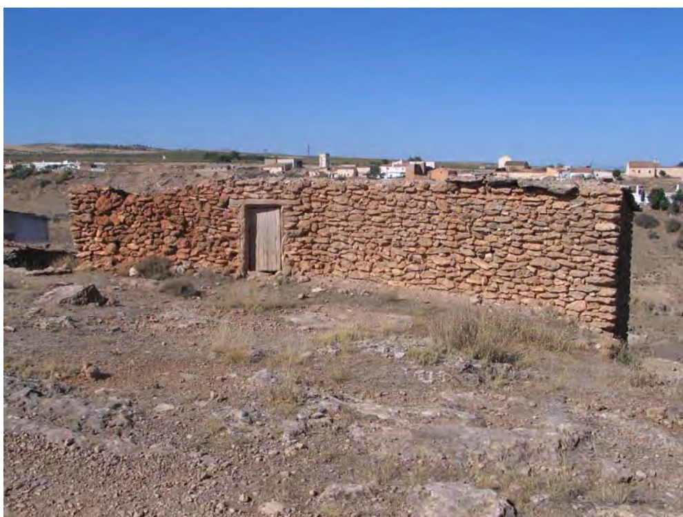
Figura 30: Construcción tradicional de caliche (El Baúl, T. M. de Guadix).
