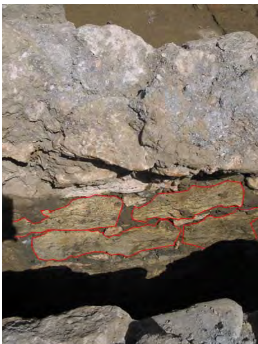
Figura 17: Fragmentos de ladrillo usados como material de construcción en el muro C, en el que predominan las lajas de caliche.
