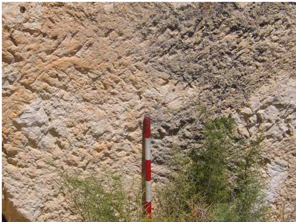
Figura 38: Detalle de la superficie del frente de extracción de las canteras de La Almida.
