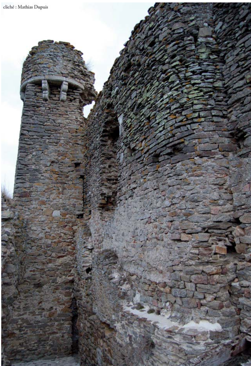
Fig. 9 : Vue de la paroi extérieure du mur ouest de la pièce 14 depuis le sud-ouest, on remarque l'angle arrondi sur lequel est appuyé le mur ouest de la pièce 11 ainsi que les relations stratigraphiques avec la tour III (Mathias Dupuis).
