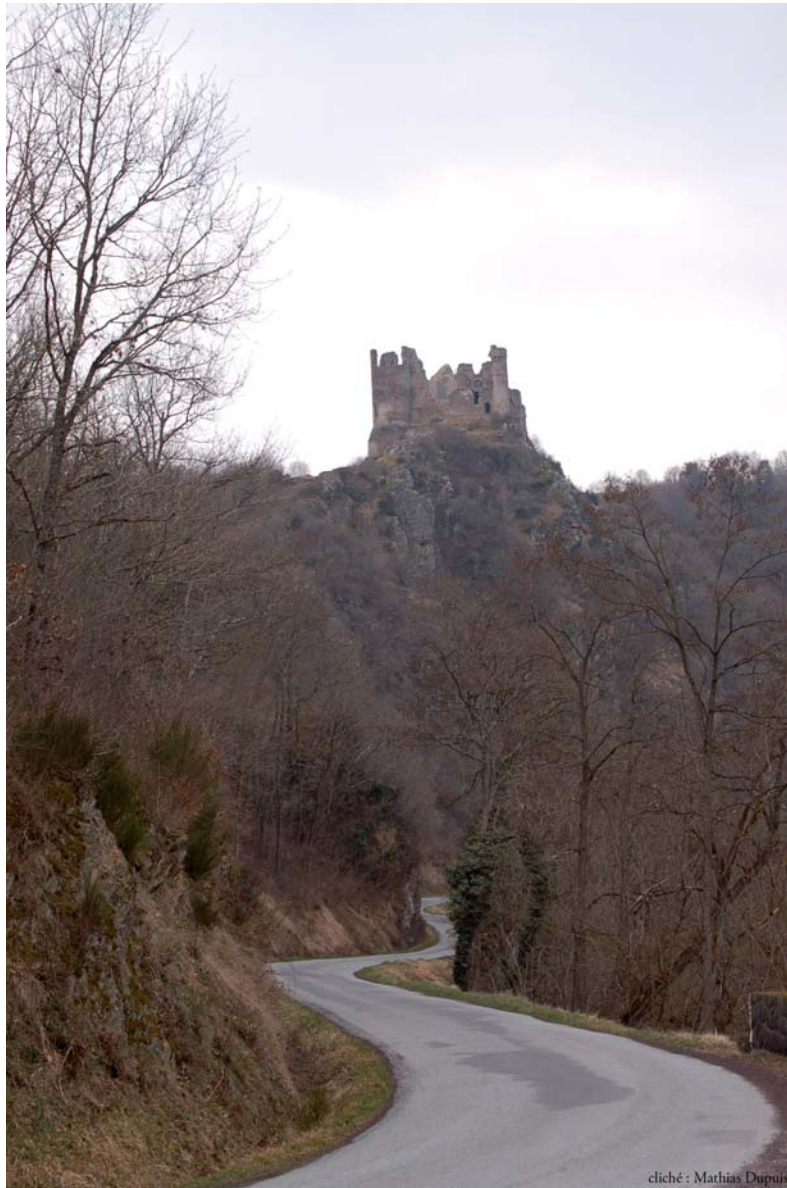
Fig. 2 : Vue du château prise depuis la route en contrebas, au nord (Mathias Dupuis).
