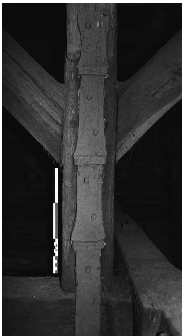
Figure 2 : Exemple d'étrier en fer dans l'église Saint-Denis à Liège renforçant l'assemblage entre un poinçon et un entrain daté par dendrochronologie du premier du tiers du XIV e siècle.
