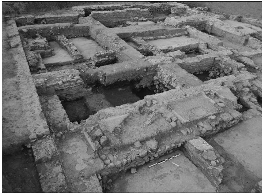
Fig. 36 – Angle nord-ouest de la villa, installation vinicole des I er et III es s. : pressoir Sud (cuves de recueil au premier plan) (cliché 2009 : M. Poux, Université Lyon-II).
