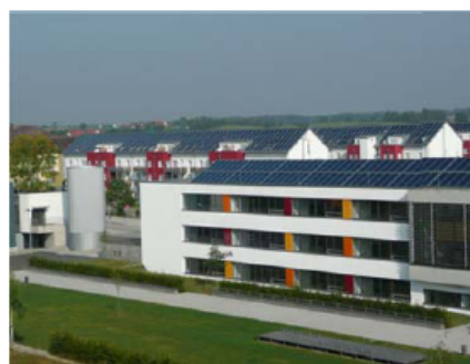
Photo 3 – Champ de capteurs solaires intégrés au bâti et connecté au réseau de chaleur de Crailsheim (Allemagne)
