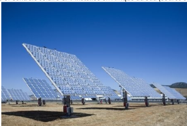
Photo 3. Centrale solaire CPV installée en Afrique du Sud (Source SOITEC)
