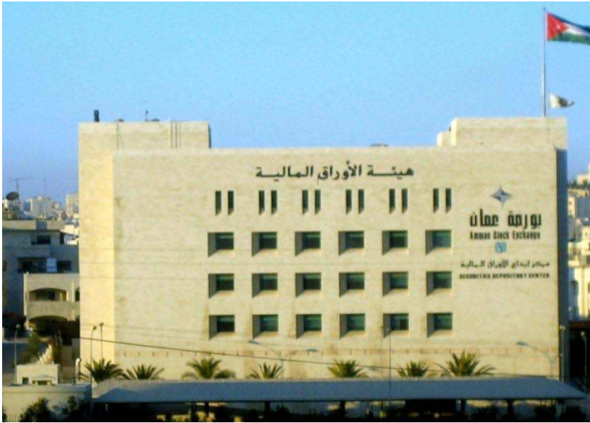
Dans les quartiers Ouest d'Amman, la bourse symbolisant la montée d'Amman dans l'économie financière internationale
