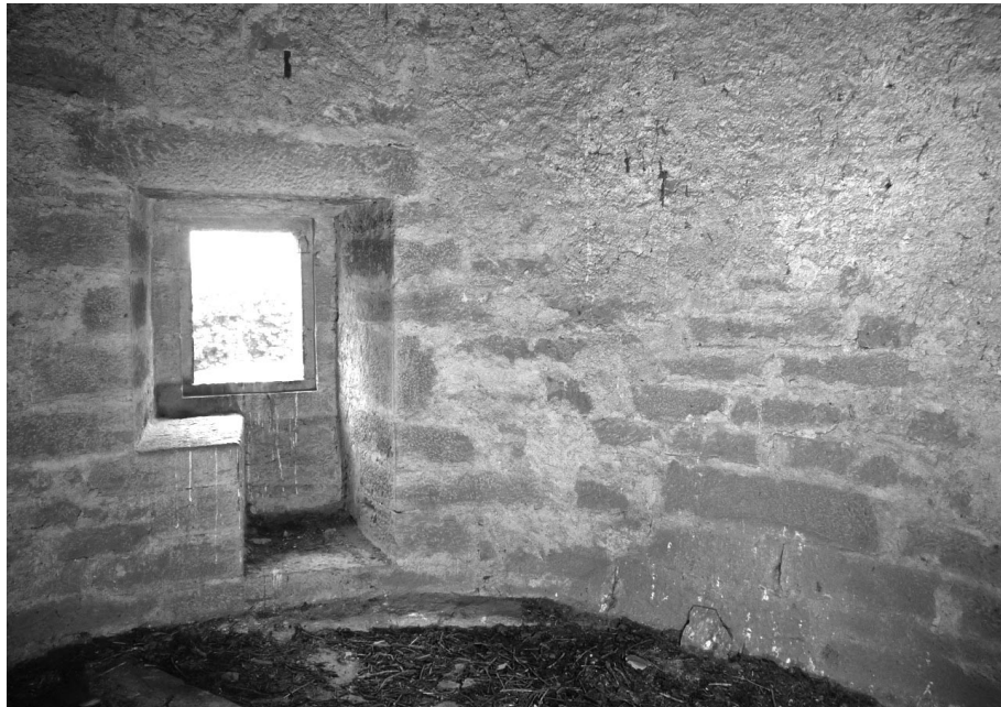
Fig. 17 : troisième niveau, fenêtre à coussiège et partie haute de la hotte de la cheminée de l'étage en-dessous. (Cl. R.P.L.)
