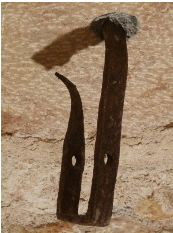
Fig. 10 : premier niveau, crochet de suspension d'une poulie, perforé de deux trous recevant l'axe de celle-ci. (Cl. R.P.L.)
