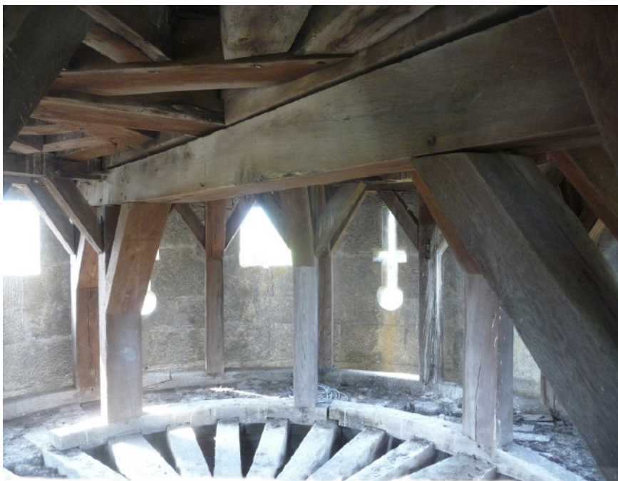
Fig. 19 : quatrième niveau, couronnement. (Cl. R.P.L.)
