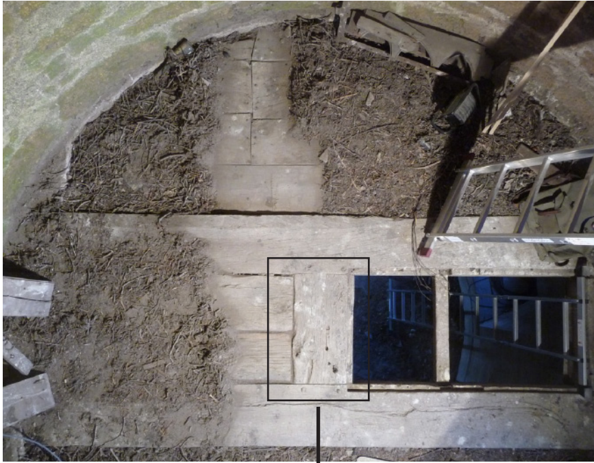
Fig. 26 : troisième niveau, structure du plancher entre le deuxième et le troisième niveau, vue plongeante. (Cl. R.P.L.)
