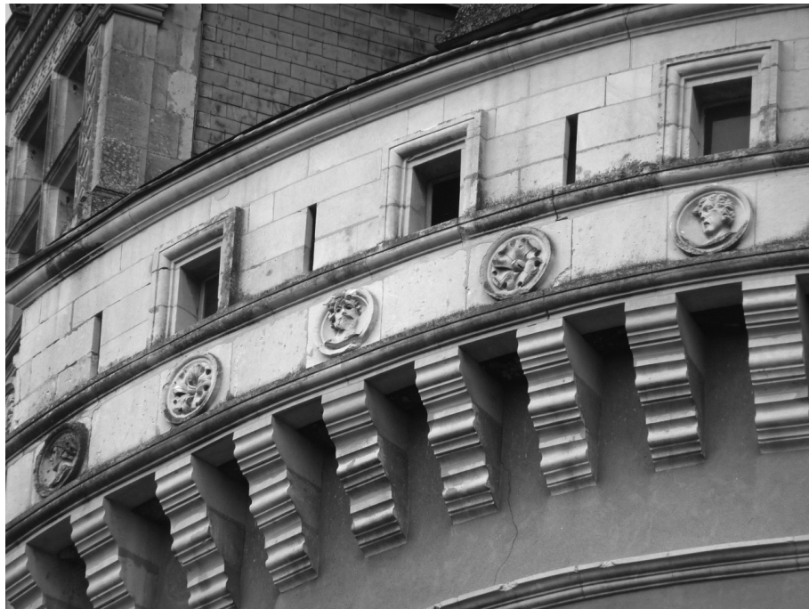
Fig. 24 : château du Lude, baies-créneaux à encadrement saillant avec un cordon continu servant d'appui. (Cl. R.P.L.)
