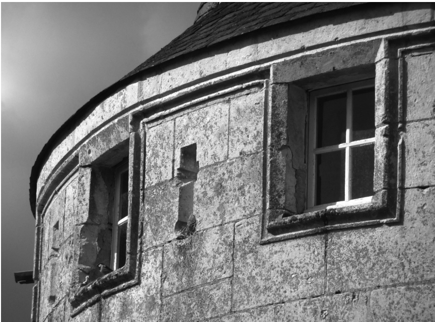
Fig. 22 : château de Frazé, tour isolée à l'est, baies-créniaux à encadrement saillant chanfreiné sur les quatre côtés. (Cl. R.P.L.)
