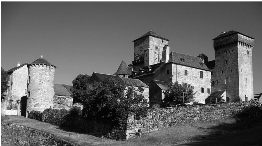
Fig. 25 : grange-château de Galinières. Vue actuelle (cl. Fr.B.)
