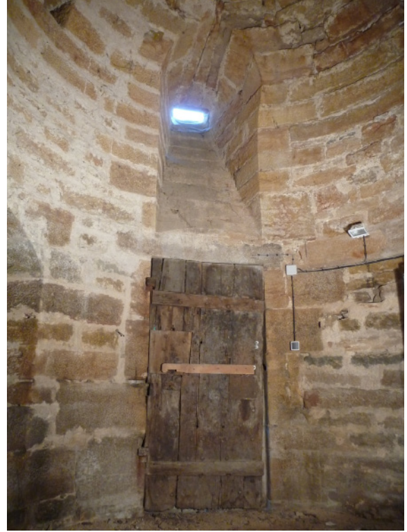
Fig. 7 : premier niveau, la porte surmontée du jour en manière de soupirail. (Cl. R.P.L.)
