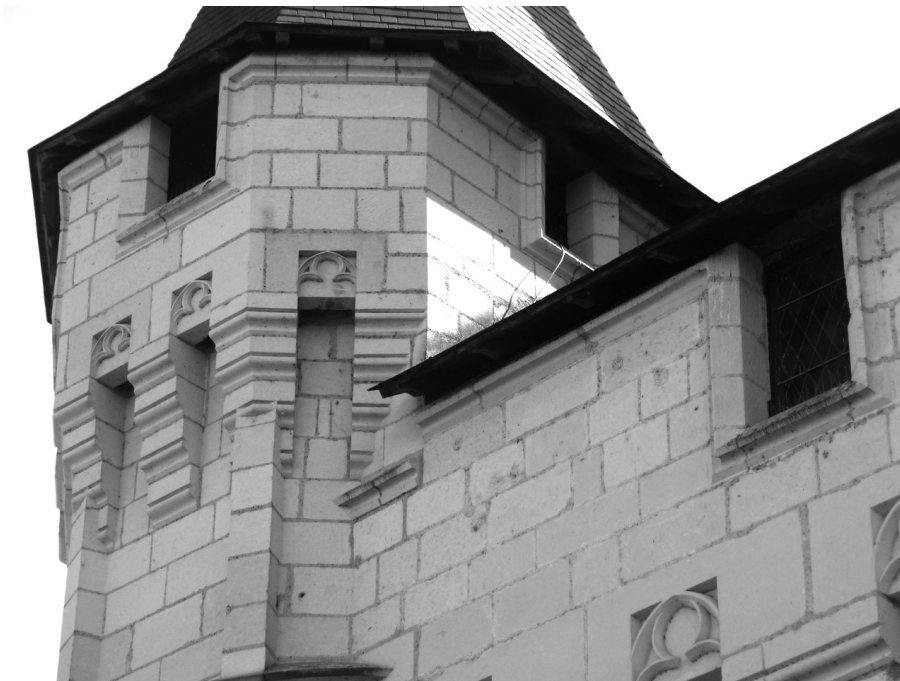
Fig. 20 : hôtel de ville de Saumur, crénelage à corniche continue sous toiture. (Cl. R.P.L.)
