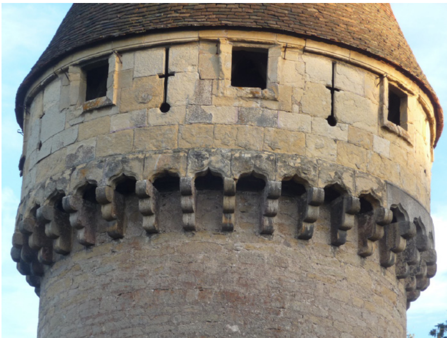
Fig. 5 : le couronnement, vu du nord-ouest. (Cl. R.P.L.)
