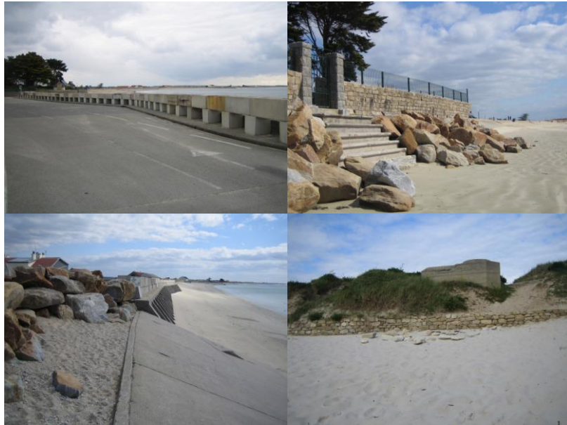
Digues et enrochements
