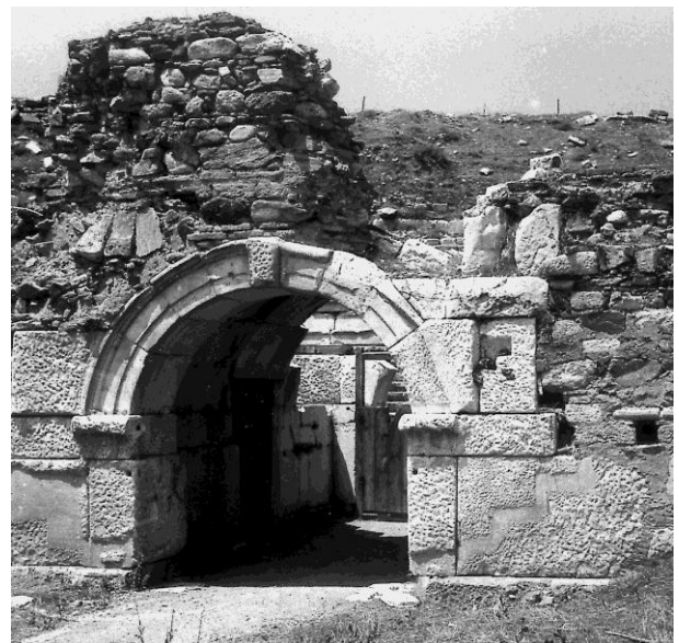
Figure 3 Traces des escaliers d'accès à la terrasse de la porticus post scaenam
