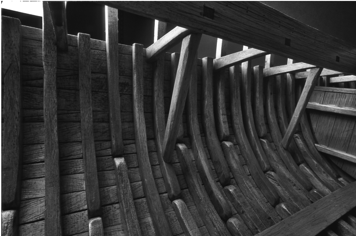
Fig. 8 : Vue de l'intérieur de la cale avec les barrotins de pont et les épointilles (photo L. Damelet, CCJ, CNRS, Aix-en-Provence).
