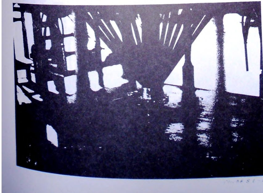
Arcs-boutants sous la grande roue (projet initial de l'ingénieur-mécanicien Le Turc copié sur le système anglais de W.Taylor)
