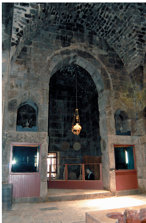
Tour 5, vue intérieure : travée rythmique de l'iwân nord (photo C. Yovitchitch).
