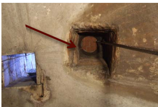
Fig. 6. Interior del aljibe. En el centro, hueco del brocal islámico. A la izquierda, una de las chimeneas de acceso.
