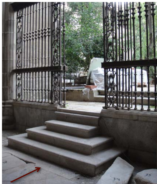
Fig. 8. Acceso al jardín que sustituyó la escalera doble que protegía el brocal islámico. (En el ángulo inferior izquierdo se aprecia una tapa del aljibe).
