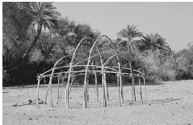
Structure en arceaux de la tente de l'Aïr
