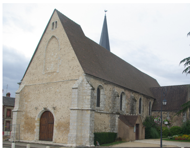
Figure 4 : vue générale de l'église Saint-Pantaléon depuis le sud-ouest
