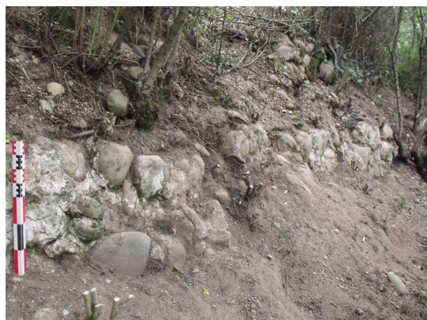
Figure 32 : vue générale du mur F10 depuis le sud-ouest
