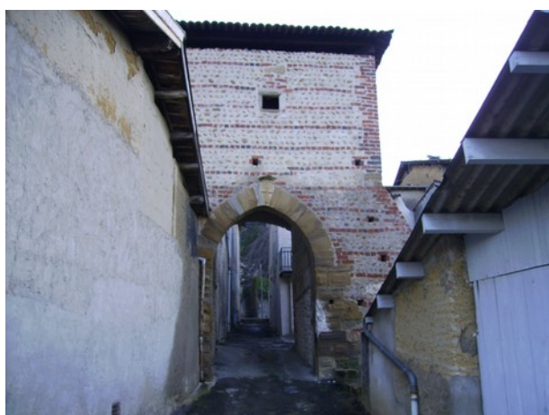
Figure 9 : façade extérieure de la porte inférieure de Moras
