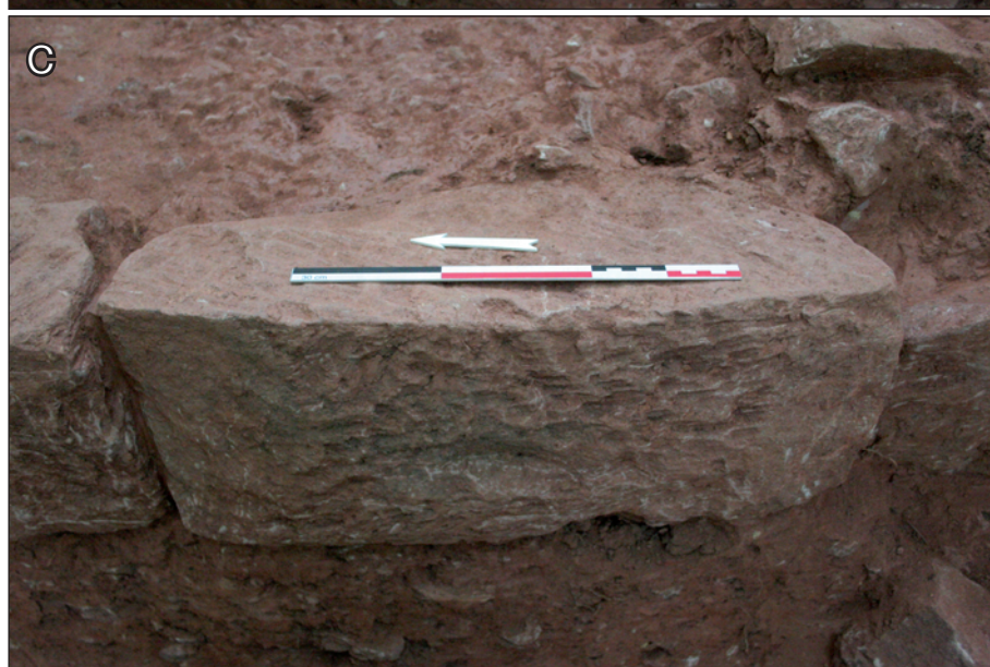
Fig. 15 : Parement a. vue frontale du tronçon dégagé dans le sondage 1 ; b et c. détail de deux blocs ; les traces de taille sont visibles sur les faces de parement et les lits d'attente.
