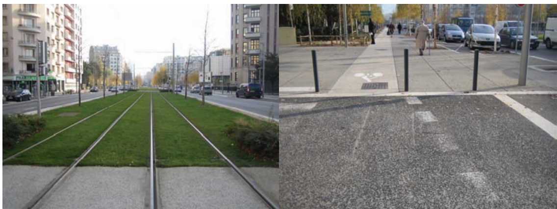
Étanchéification et canalisation des flux (photos RT)
