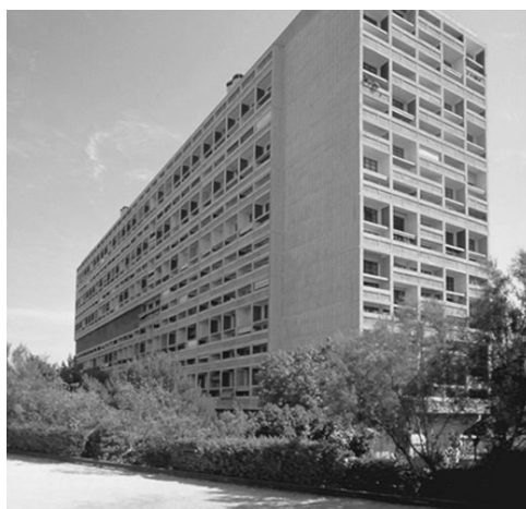
L'unité d'Habitation de Marseille et le principe du brise-soleil
