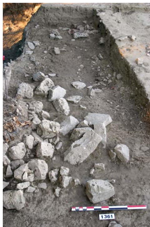
■ Fig. 290 : Vue depuis le sud du secteur 10 avec au premier plan l'amas de blocs en calcaire résultant de l'effondrement du mur MR78086 (78112).
