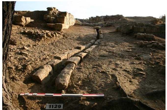
■ Fig. 49 : Vue générale du caniveau CN72051 traversant la rue 10, depuis le sud. Sur la bordure ouest, le niveau de circulation avec galets 71190.
