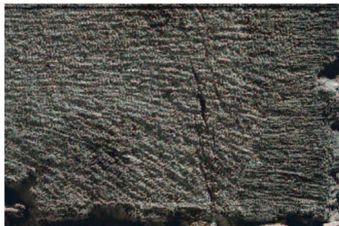
Figure 22. Bloc de l'embrasure est : impacts de marteau taillant et ciselure périmétrale (cliché A. Hartmann-Virnich, 2002)
