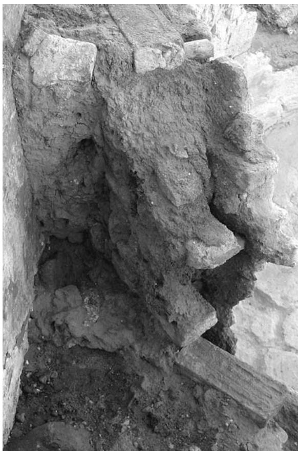
Fig. 5 : Vue de l'écoinçon "sud-est" et structure de la paroi du four à barres avec les remplois (cliché J.T.).
