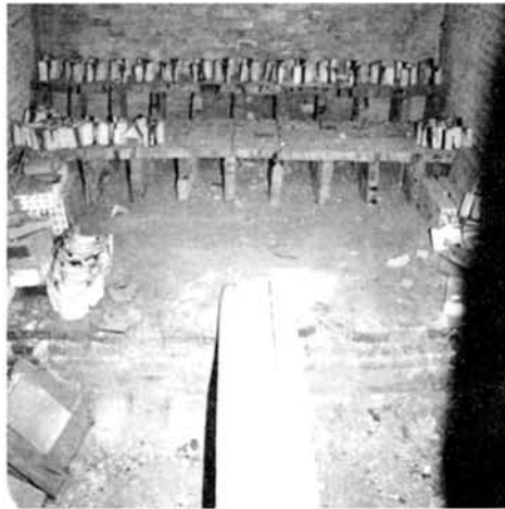
fig. 2 – Sagén du four “actuel” de Francisco Giner à Paterna en cuisson oxydante avec la planche qui permet de passer au dessus du foyer pour charger (AMIGUES, MESQUIDA 1990, p. 145, fig. 2).
