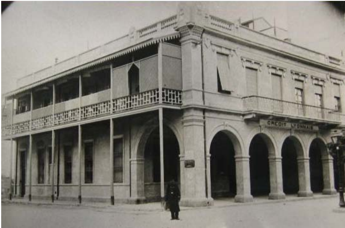
Bâtiment à arcades : l'agence du Crédit lyonnais à Port-Saïd en 1912. Archives historiques de LCL-Le Crédit lyonnais, P-NB-2-0289.
