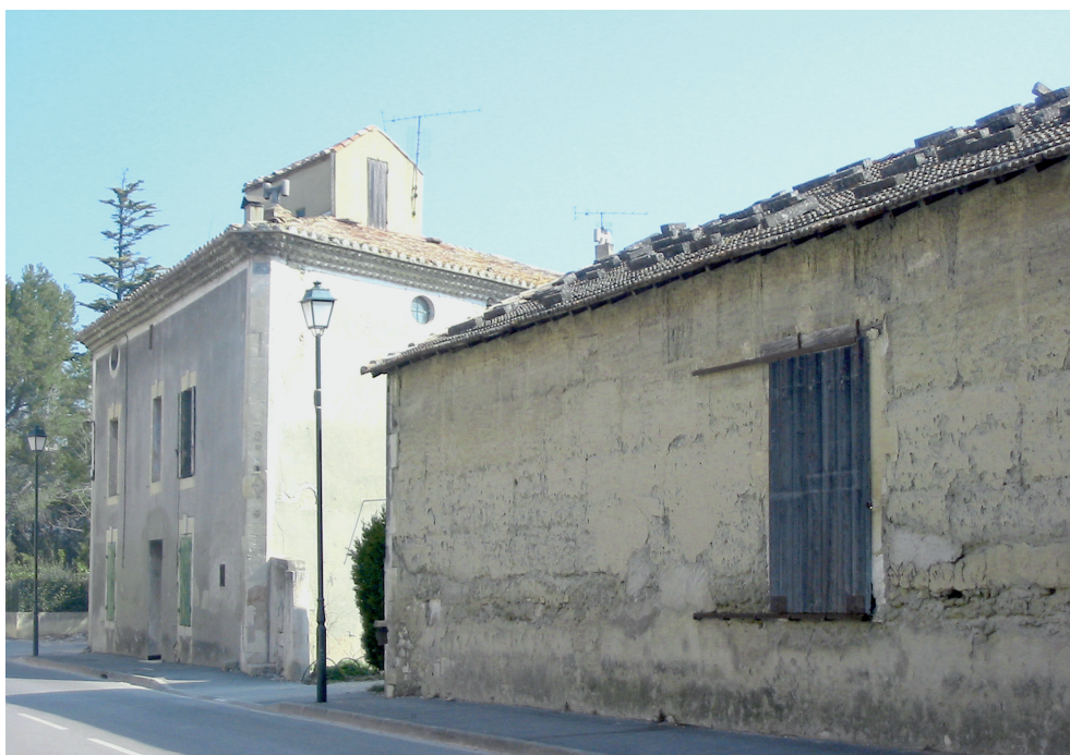
Fig. 17 : Maillane (13). Maison d'habitation et remise construites en pisé au sein d'îlots créés au XIX e s. (C.-A. de Chazelles, CNRS)
