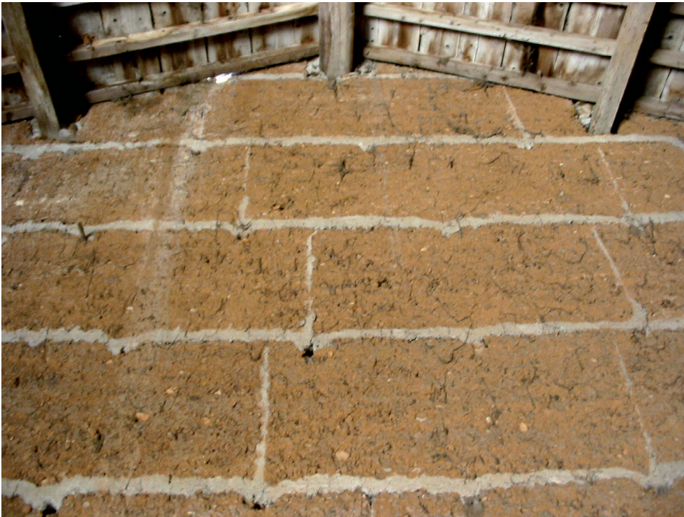
23 : Intérieur de la bergerie de Nègreiron : pignon en pisé (H. Gazzal)
