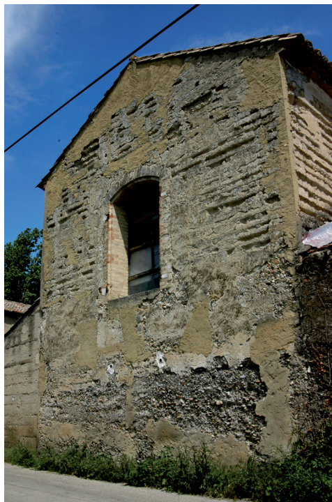
Fig. 16 : Mas construit avec une technique mixte pisé/béton dans la plaine d'Avignon (F. Guyonnet, S.A.D.V.)
