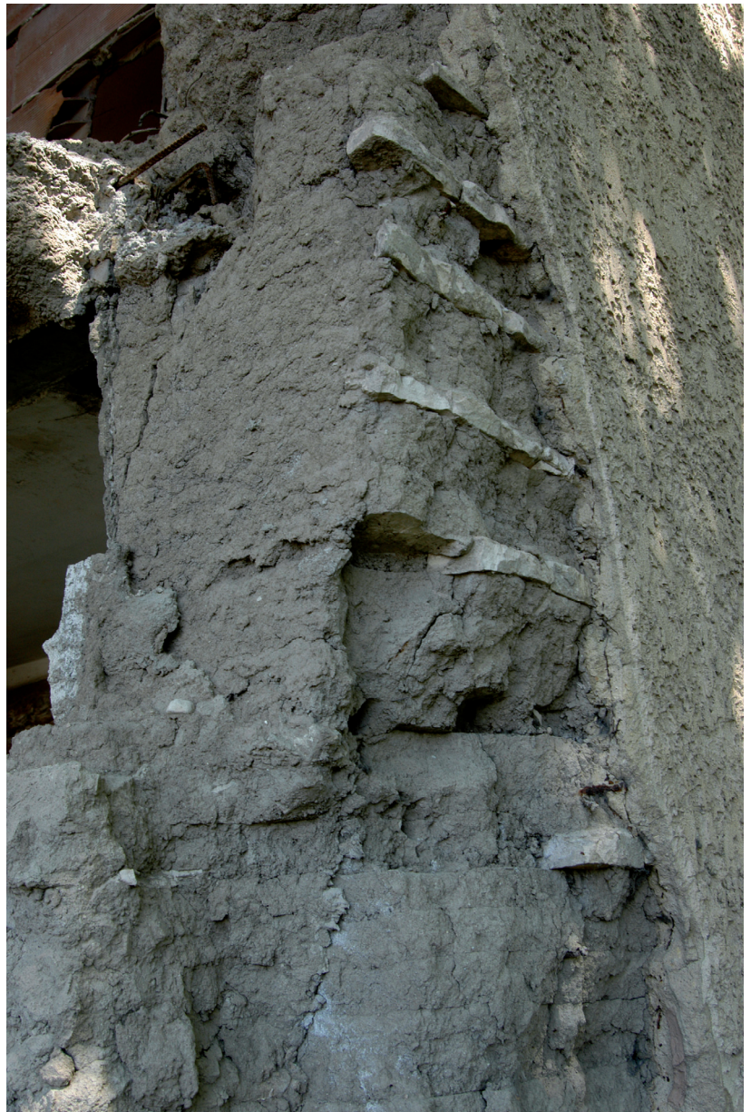
Fig. 15 : Détails d'un mur ruiné en pisé aux environs de Monteux. On observe le système d'accroche de l'enduit (F. Guyonnet, S.A.D.V.)
