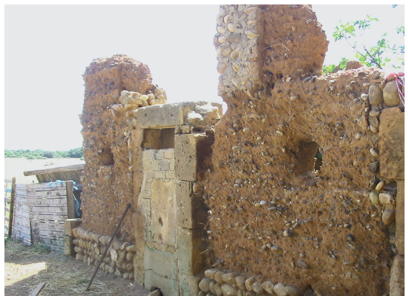
Fig. 22 : Mur en pisé d'un bâtiment annexe dans la cour de la bergerie de Negreiron, détail du matériau rempli de galets (C.-A. de Chazelles, CNRS)
