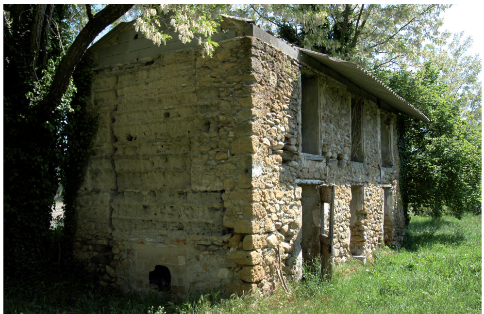
Fig. 13 : Petit bâtiment en pisé avec façade en pierre dans la plaine de la Durance à Villelaure dans le Vaucluse (F. Guyonnet, S.A.D.V.)
