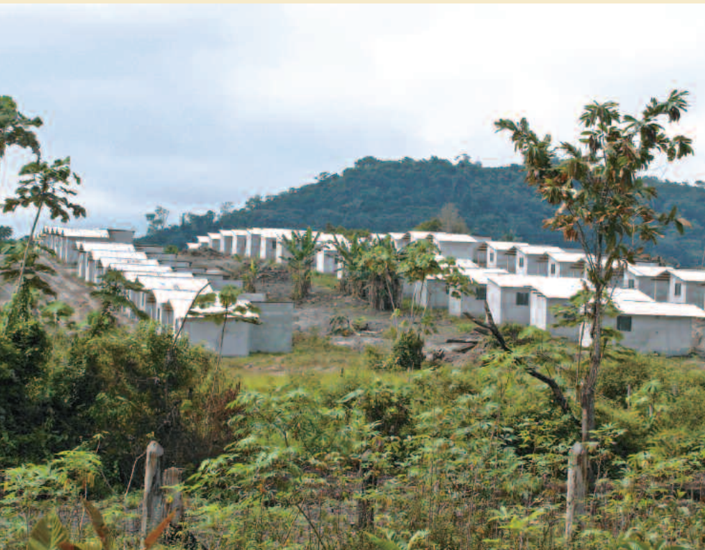
Photo 2. Des abattis aux portes de la ville. Photo L. Eloy.
