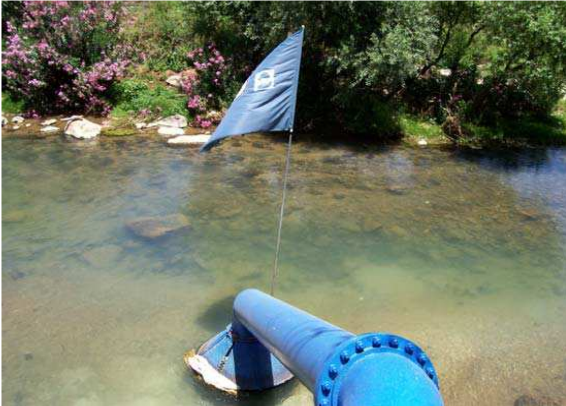
Photo 3 : L'eau est au coeur de la géopolitique. Ici, une pompe dans le Hasbani-Wazzani (Sud-Liban) avec le drapeau d'un mouvement politique libanais.
