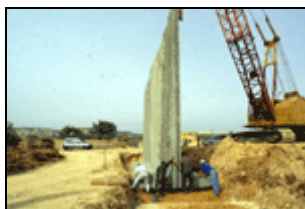
Bethléem, le mur en construction (2004)
