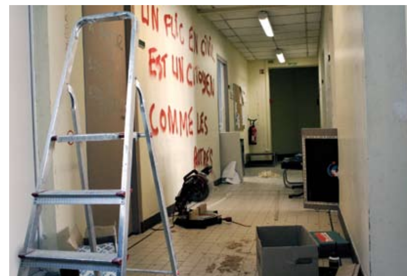
Fig. 28. Remise en état des lieux, 7 avril 2006.
