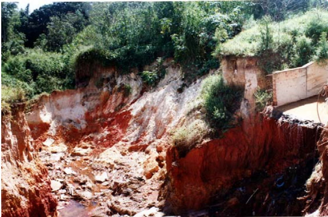
Photo 28 : Erosion sur le Riacho Fundo.
