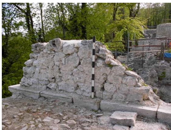
Cliché nord du MUR 321.
