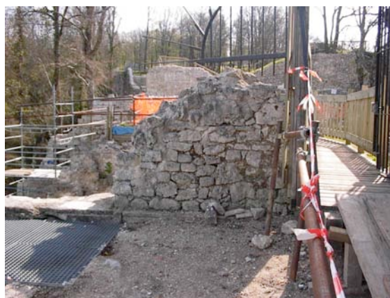
Cliché sud du MUR 321.
