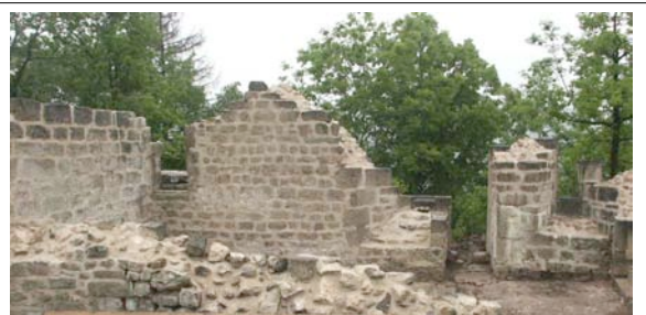
Cliché nord du MUR430a après consolidation.
