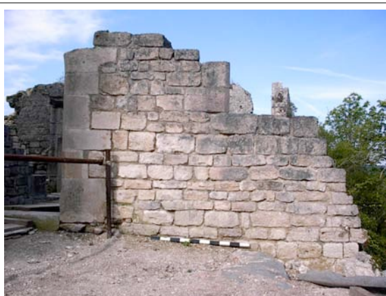
Cliché est du MUR 425.
