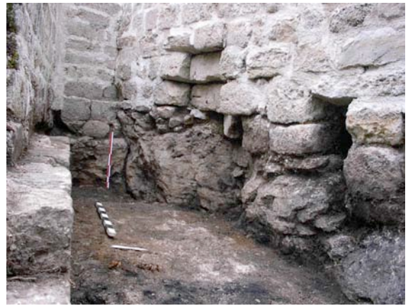
Cliché est du ressaut et de la réservation.
