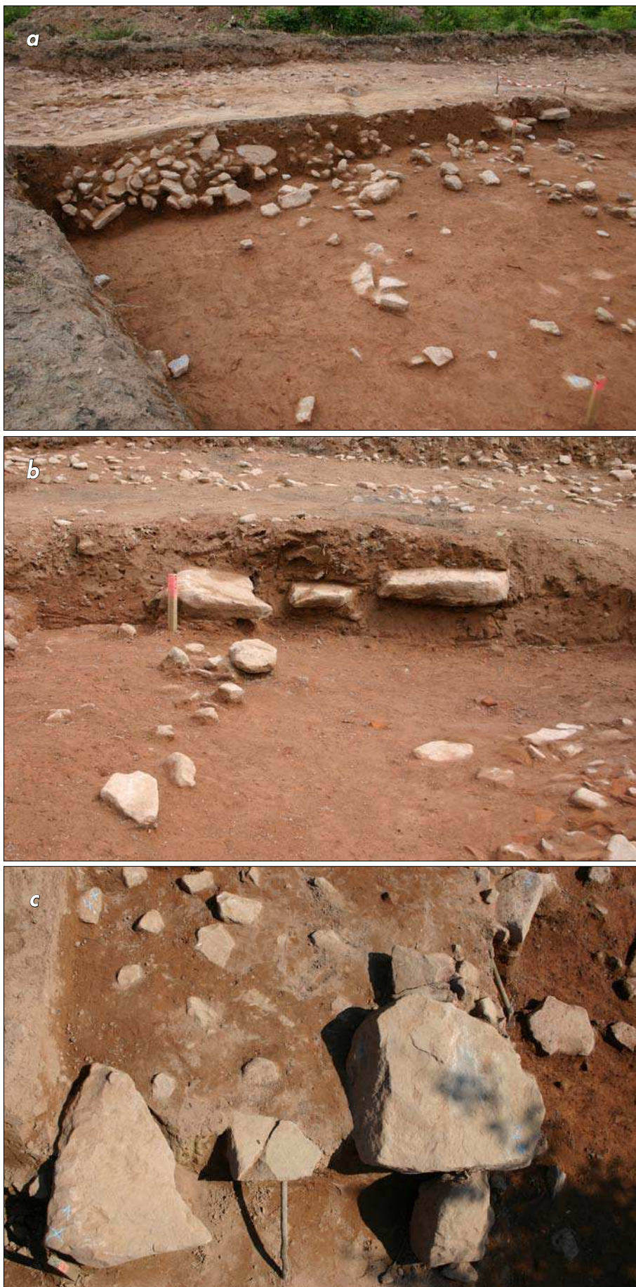
Fig. 8 : Aménagement de bord de terrasse au niveau du sondage A (photo 7a) et du sondage B (photos 7b et c).
