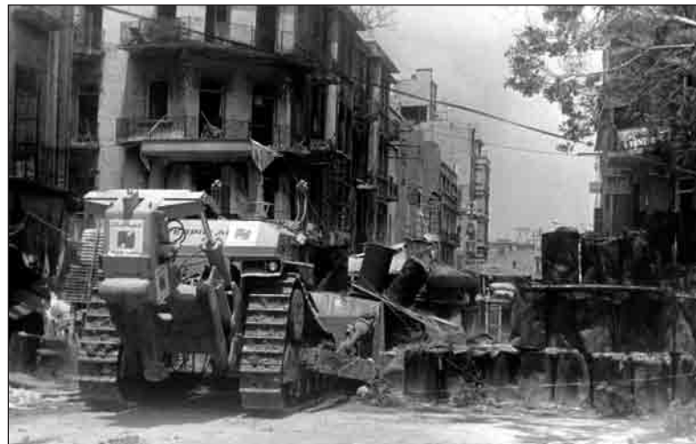
Le déblaiement du centre de Beyrouth en vue de la reconstruction, janvier 1983, place Debbas. On distingue sur le bulldozer le logo de l'entreprise OGER Liban.
