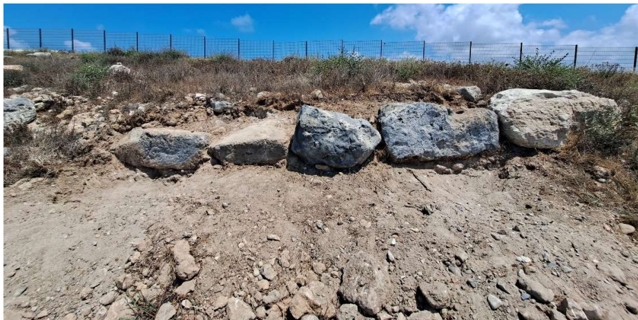
Fig. 64. L'assise de blocs après nettoyage : elle repose sur la terre. Vue vers le Nord. Cliché : C. Balandier/Mafap.
