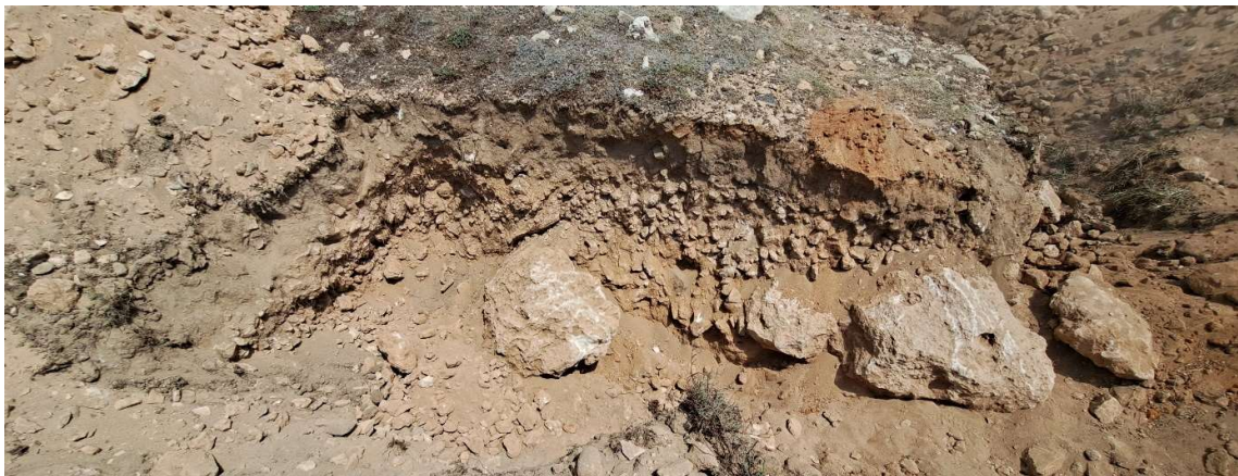
Fig. 53. Cap Maloutena : extrémité sud du rempart Ouest. Blocs de fondation du parement Ouest. Vue vers l'Est. © C. Balandier/MafâP
