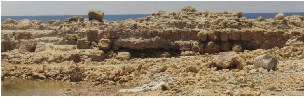
Fig. 65. Rempart Sud : face Nord avec assises de boutisses (état en 2015). Vue vers le Sud. Cliché : C. Balandier
