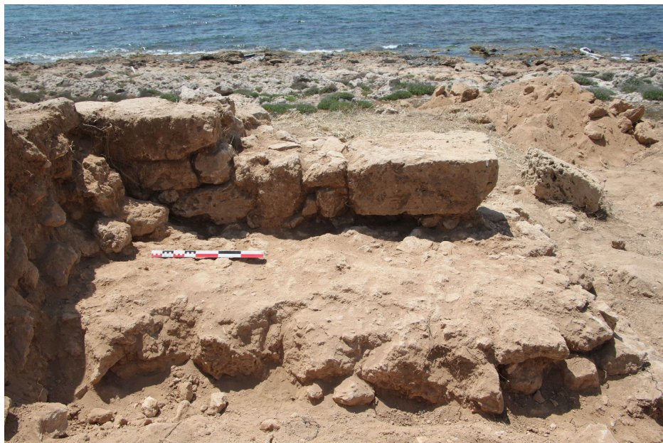
Fig. 29. Niveau plan sous le lit de pose de l'assise de blocs de taille. Vue vers l'Ouest. Cliché : Mañap/M. Tastayre.
