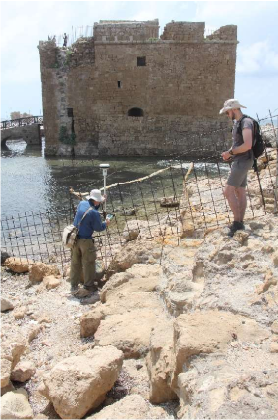
Relevés du rempart Sud à l'ouest du kastro (château ottoman). Vue vers l'Est.
