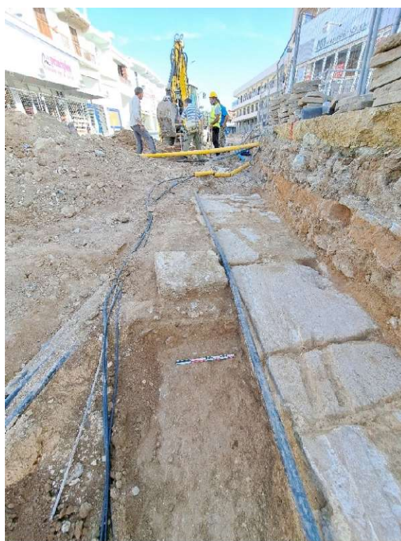
Fig. 93. Odos Artemidos. Lit d'attente de l'assise de blocs conservés et sol contre son parement Ouest. Vue vers le Nord. Cliché : MafâP/C. Balandier.
