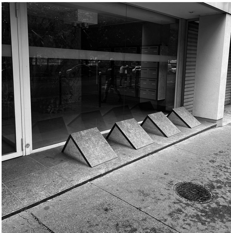
Fig. 4 – Dispositif urbain défensif pour éviter tout usage informel devant une entrée d'immeuble à Paris.
