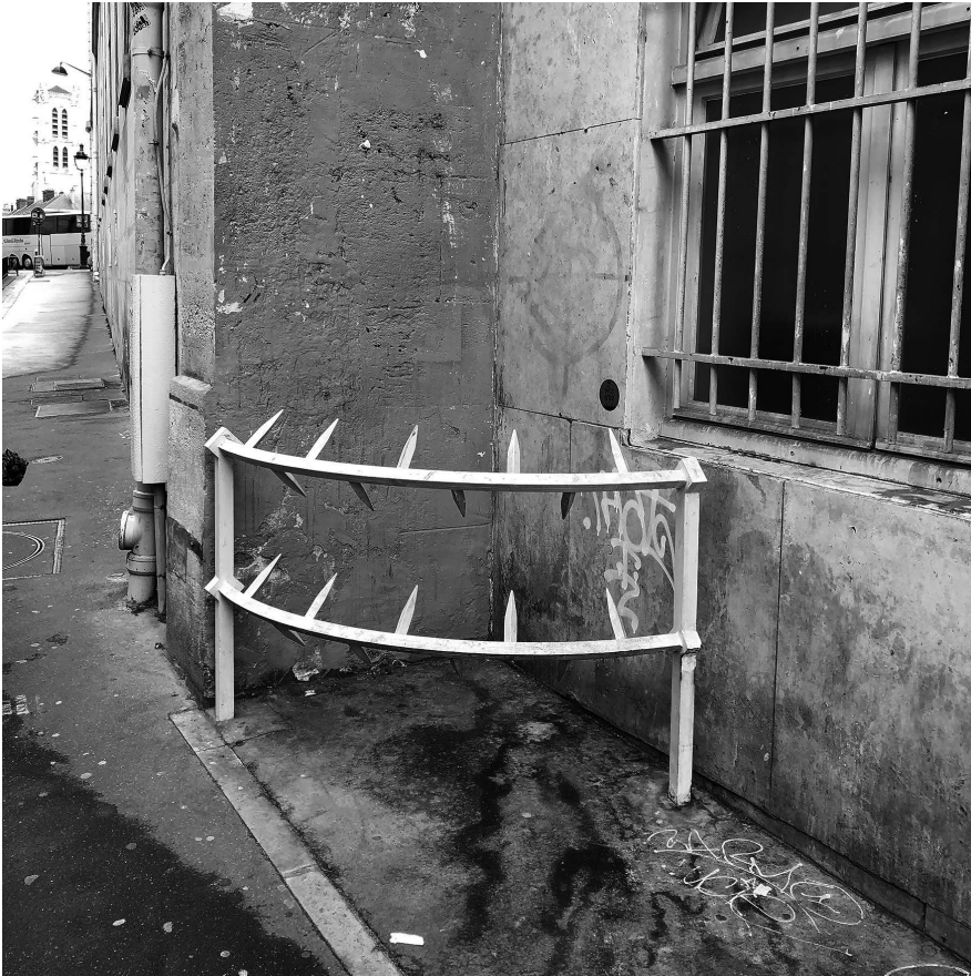
Fig. 5 – Dispositif urbain défensif pour éviter tout usage informel d'un coin de rue à Paris.
