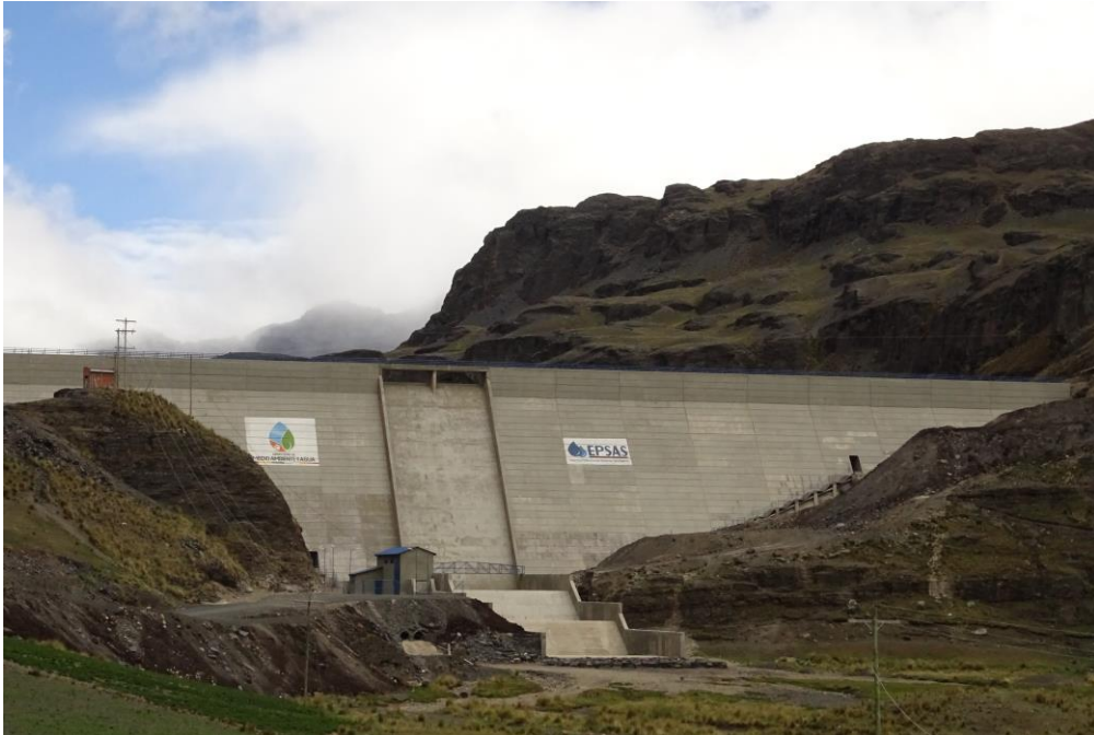
Photo 6 : L'un des réservoirs d'EPSAS dans l'ayllu Hampaturi
