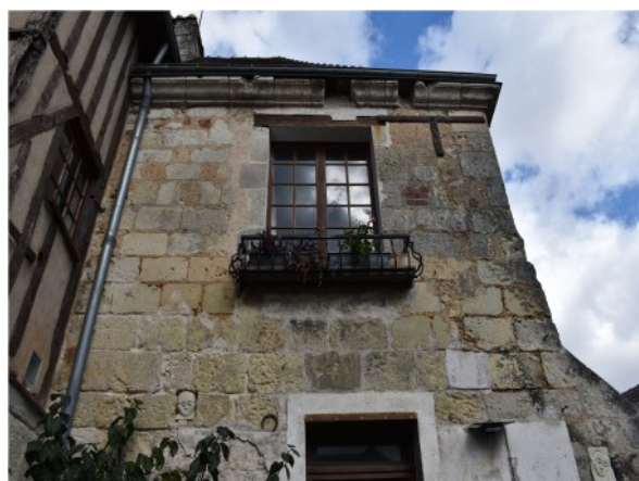
Figure 148 : Ensemble bâti 0708, Mur gouttereau Sud du bâtiment
