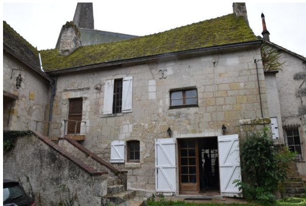
Figure 33 : Prieuré de Lunay : La façade sur cour du bâtiment sud
