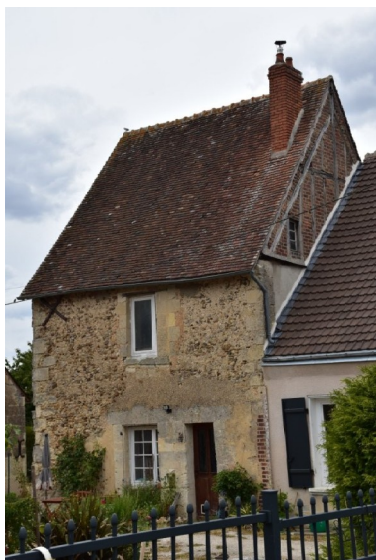
Figure 53 : Bâtiment 7 rue de la Fontaine à Artins, avec un pignon découvert à l'arrière (corpus 0004)
