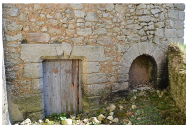
Figure 209 : Ensemble bâti 1900, Les deux portes situées à l'arrière du bâtiment au niveau du comble
