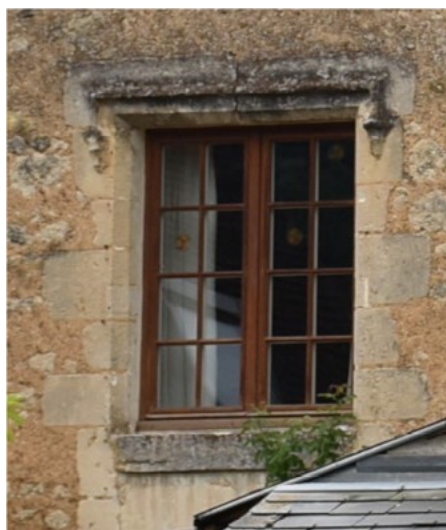
Figure 182 : Ensemble bâti 1052, Vue de la croisée simple sur le pignon du corps perpendiculaire
