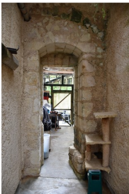
Figure 218 : Ensemble bâti 2013, Porte à arrièrevoussure du couloir
