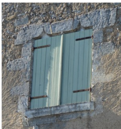
Figure 207 : Ensemble bâti 1900, Détail de la croisée de l'étage
