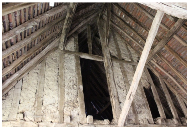
Figure 65 : Charpente d'un des bâtiments de la Haloperie (Fontaine) (corpus 0200)
