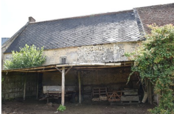
Figure 199 : Ensemble bâti 1701, Vue de la façade nord du logis
