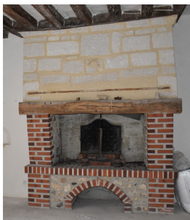
Figure 42 : Prieuré de Lunay : Cheminée du 16 e siècle sur le pignon nord du bâtiment Est
