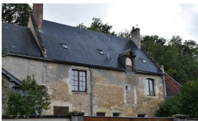
Figure 193 : Ensemble bâti 1500, Vue générale du logis
