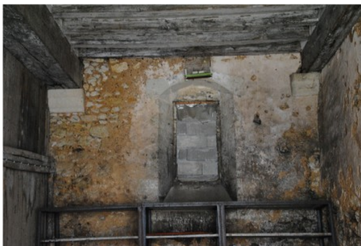
Figure 180 : Ensemble bâti 1024, Vue intérieure d'une baie
