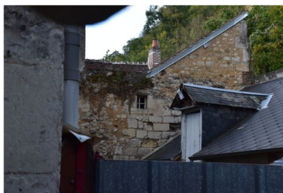
Figure 150 : Ensemble bâti 0709, Vue du corps de bâtiment depuis le Nord
