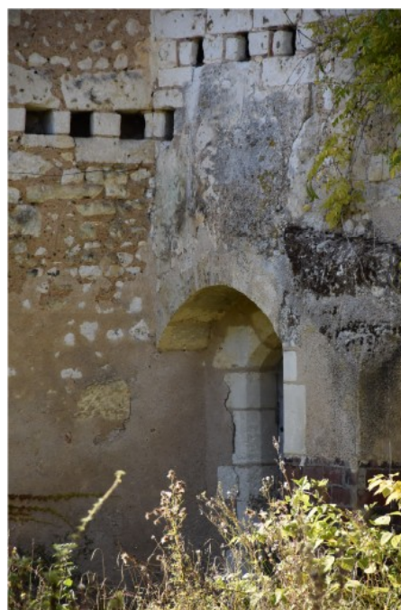
Figure 158 : Ensemble bâti 0816, Porte dans le coteau
