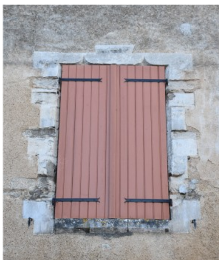
Figure 203 : Ensemble bâti 1903, Détail de la croisée
