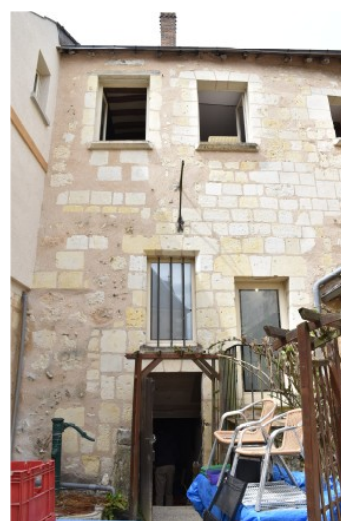
Figure 212 : Ensemble bâti 2001, Vue du mur gouttereau sud (la partie la plus ancienne du bâtiment, des 12 e -13 e siècles)
