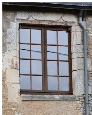
Figure 196 : Ensemble bâti 1500, La croisée simple à double accolade
