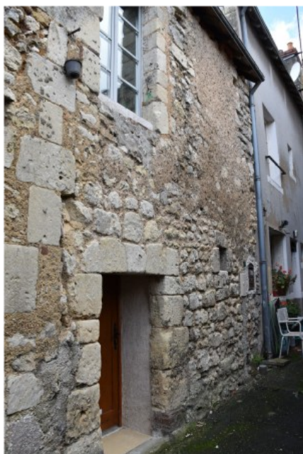
Figure 153 : Ensemble bâti 0714, Vue du mur nord du bâtiment
