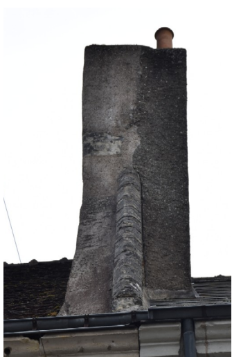
Figure 18: Exemple de rampant chanfreiné à Montoire (corpus 1050)
