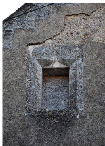
Figure 204 : Ensemble bâti 1903, Détail de la baie du comble
