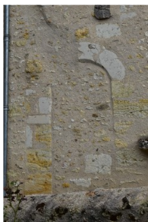
Figure 161 : Ensemble bâti 0821, Détail de la porte bouchée au niveau 1
