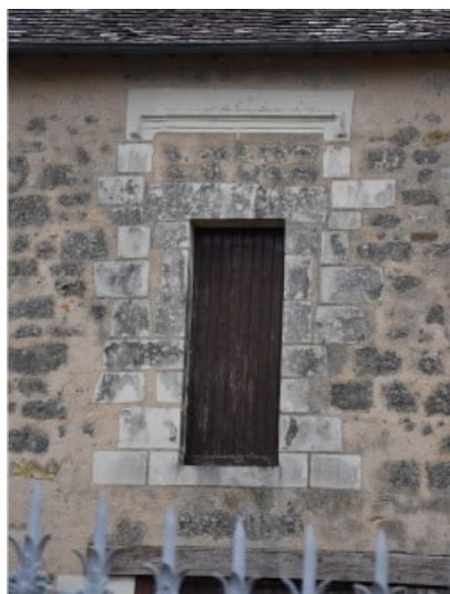
Figure 176 : Ensemble bâti 1064, Détail de la croisée ouest
