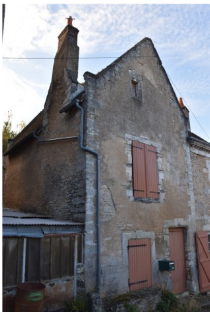
Figure 201 : Ensemble bâti 1903, Vue générale du bâtiment
