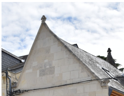
Figure 16: Exemple de pignon asymétrique aux rampants arrondis (corpus 1016)
