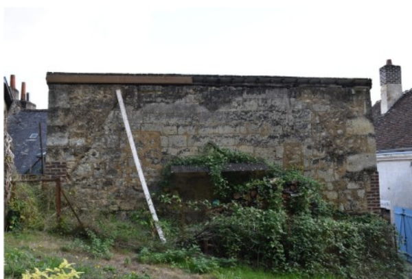
Figure 149 : Ensemble bâti 0709, Vue du pignon ouest en moyen appareil
