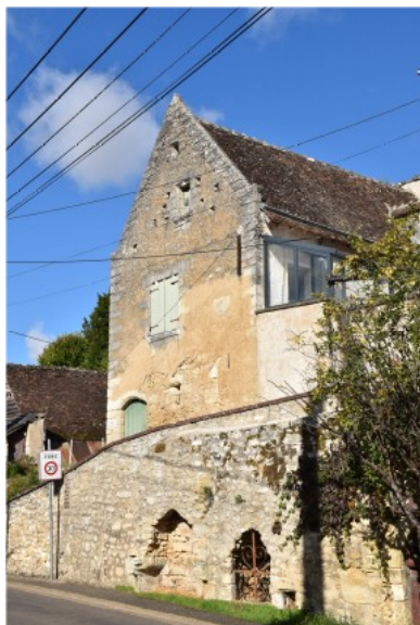
Figure 205 : Ensemble bâti 1900, Vue générale du bâtiment
