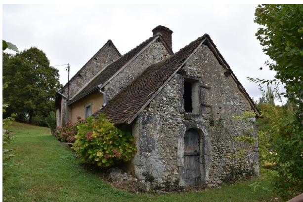
Figure 115 : Ensemble de bâtiments dont le dernier a une charpente de la fin du Moyen Âge (corpus 1602)
