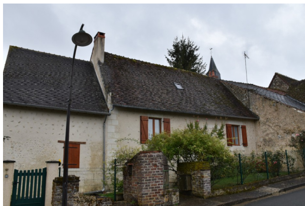
Figure 68 : Bâtiment à pignon découvert, 6 route de Mazangé à Fortan (corpus 0301)
