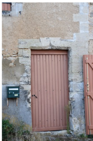
Figure 202 : Ensemble bâti 1903, Détail de la porte d'entrée
