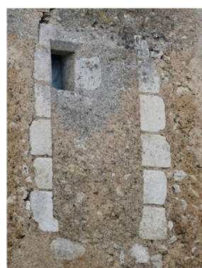
Figure 194 : Ensemble bâti 1500, Détail de la baie située à mi-niveau
