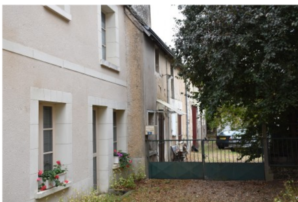
Figure 169 : Ensemble bâti 0807, Vue générale du bâtiment depuis la rue
