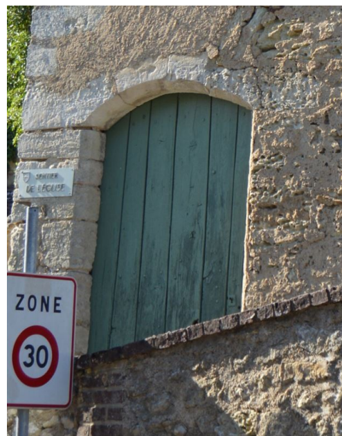
Figure 206 : Ensemble bâti 1900, Détail de la porte d'entrée
