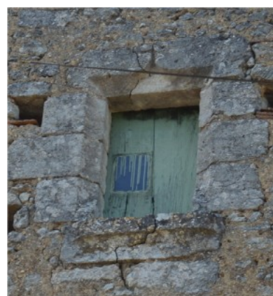
Figure 210 : Ensemble bâti 1900, Baie à accolade du comble
