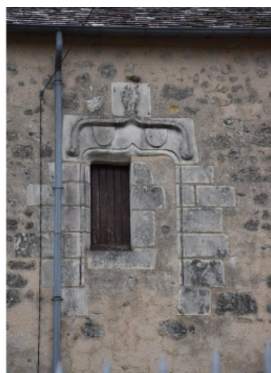
Figure 177 : Ensemble bâti 1064, Détail de la croisée centrale
