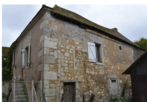
Figure 37 : Prieuré de Lunay : Façade est du bâtiment Est, traces d'une porte bouchée et d'un arrachement de mur où la corniche est interrompue
