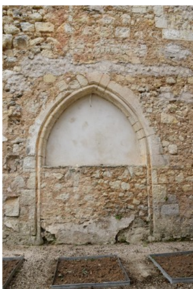
Figure 191 : Ensemble bâti 1007B, Détail de l'arc brisé
