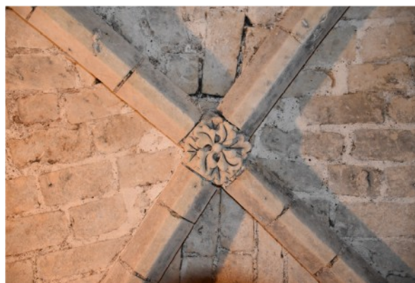
Figure 219 : Ensemble bâti 2013, Détail de la clé de voûte de la cave dans le coteau
