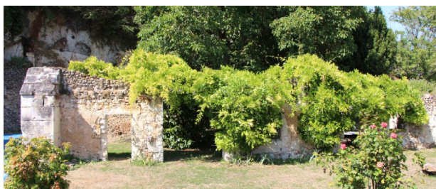
Figure 64 : Bâtiment partiellement ruiné avec croisée et contreforts à la Poularderie (Fontaine) (corpus 0200)
