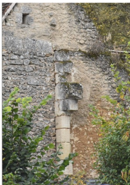
Figure 168 : Ensemble bâti 0830, Détail du jambage de la cheminée
