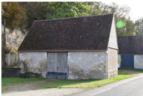
Figure 143 : Grange chemin des Pins à Villavard (corpus 2106)
