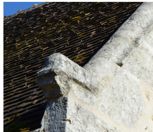
Figure 28: Exemple de chapeau de gendarme avec retour sur crossette à ressauts (corpus 1901)
