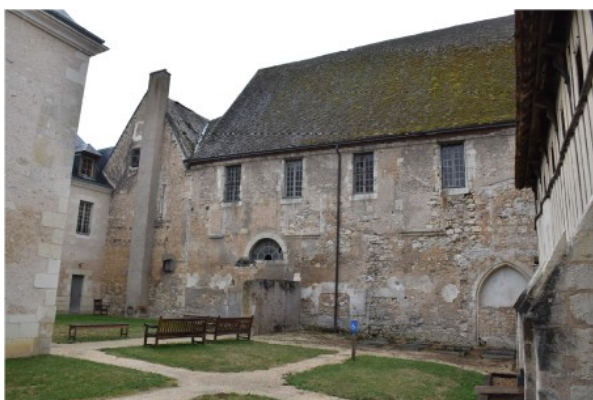
Figure 189 : Ensemble bâti 1007B, Vue du mur nord du bâtiment
