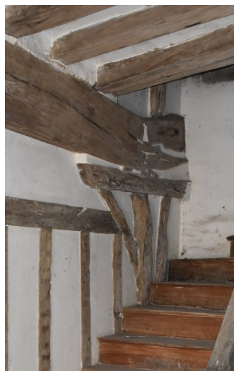
Figure 41 : Prieuré de Lunay : Sommier reposant sur un poteau en bois à l'étage du bâtiment Est.
