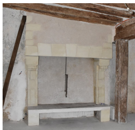
Figure 43 : Prieuré de Lunay : Cheminée du 16 e siècle dans la pièce sud du bâtiment Est, sur le mur mitoyen avec l'autre bâtiment
