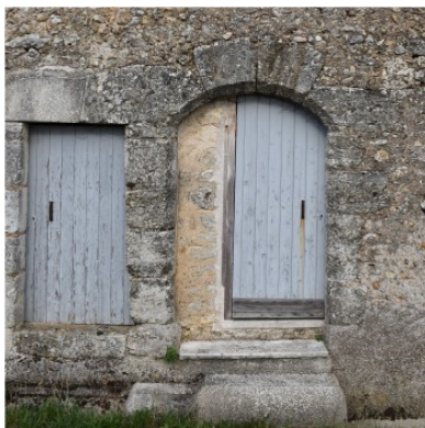
Figure 165 : Ensemble bâti 0823, Détail de la porte du rez-de-chaussée
