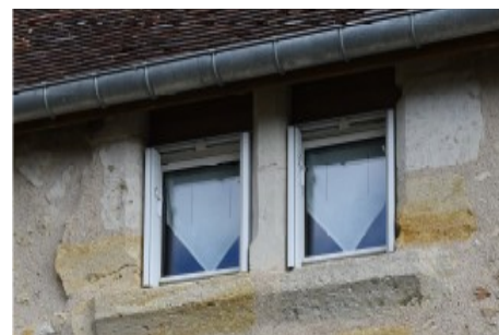
Figure 163 : Ensemble bâti 0821, Détail de la croisée
