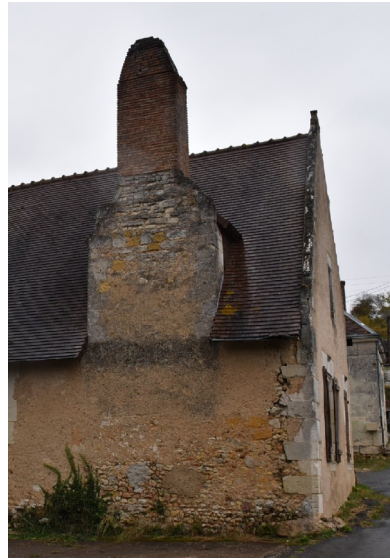
Figure 82 : Maison à cheminée rue du Tertre de Calais à Lunay (corpus0813)
