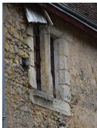
Figure 174 : Ensemble bâti 0802, Détail de la croisée sur la façade nord
