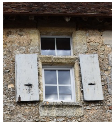
Figure 166 : Ensemble bâti 0823, La demi-croisée côté rue
