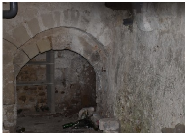
Figure 146 : Ensemble bâti 0100, Porte dans la cave
