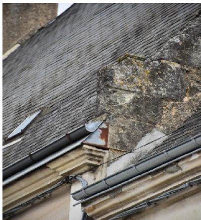
Figure 14: Exemple de base de pot-à-feu sur crossettes (corpus 1018)
