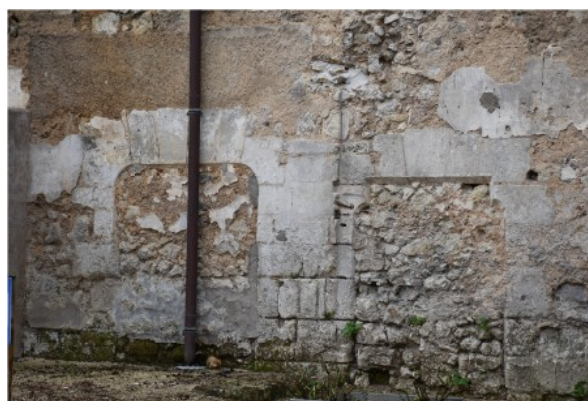
Figure 190 : Ensemble bâti 1007B, Vue de la porte à coussinets
