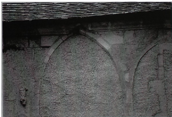
Figure 35 : Prieuré de Lunay : Baies en arcs brisés dans la façade sur rue du bâtiment Sud, masqués sous la végétation dans la figure précédente (MICHEL 1998)
