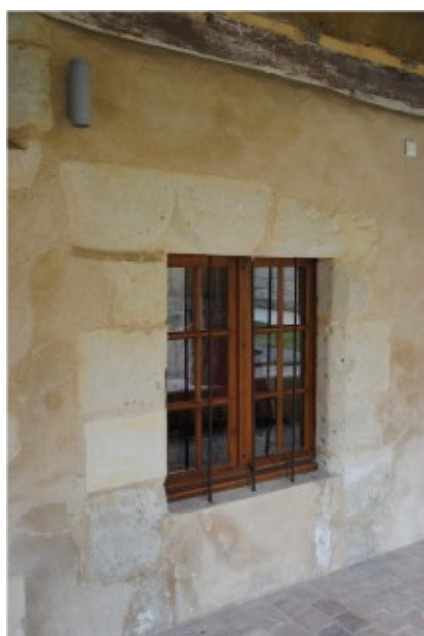
Figure 187 : Ensemble bâti 1007A, Détail de la baie à accolade du rez-de-chaussée côté est
