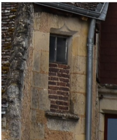
Figure 183 : Ensemble bâti 1052, Baie à accolade de la tourelle d'escalier
