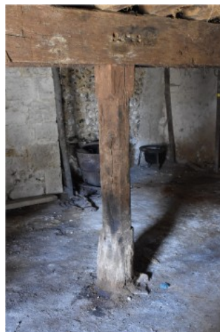
Figure 198 : Ensemble bâti 1701, Détail du pilier dans la cave
