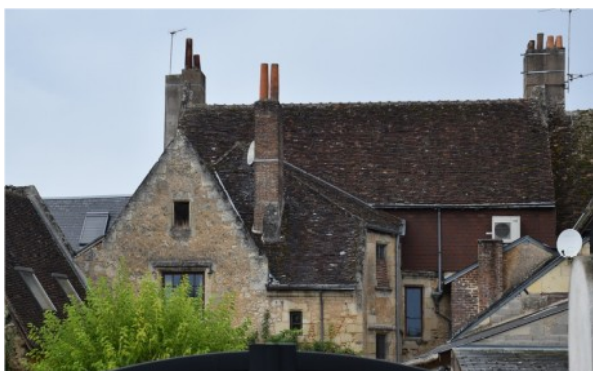
Figure 181 : Ensemble bâti 1052, Vue de l'arrière du bâtiment avec le corps perpendiculaire et la tourelle d'escalier
