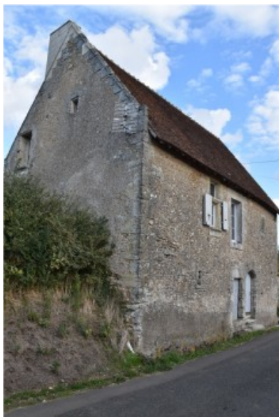
Figure 164 : Ensemble bâti 0823, Vue générale du logis
