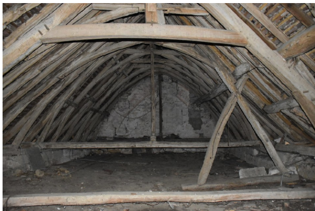
Figure 44 : Prieuré de Lunay : Charpente à chevrons formant ferme du bâtiment Sud et pignon ouest peint
