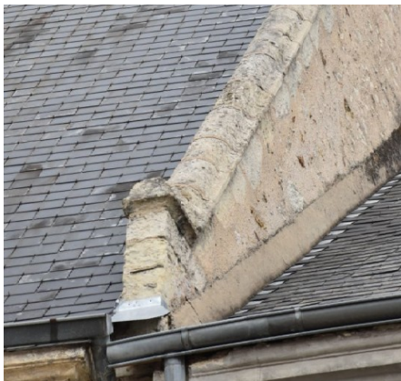
Figure 27: Exemple de chapeau de gendarme avec retour sur crossette simple (corpus 1005)
