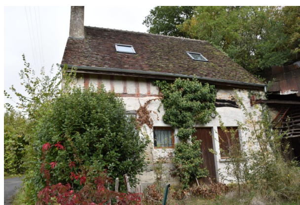
Figure 73 : Logis en partie en pans de bois à la Marsolière à Lavardin (corpus 0519)
