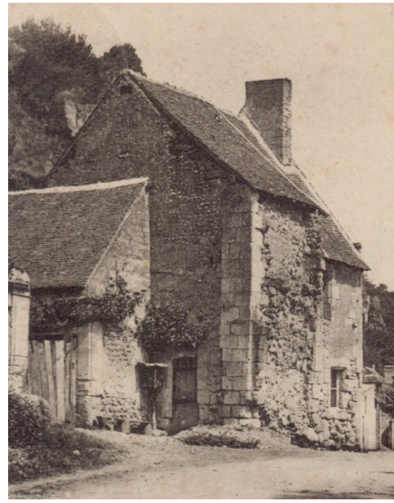
Figure 77 : Bâtiment contre l'enceinte sud (détruit) aux Roches (corpus 0700)
