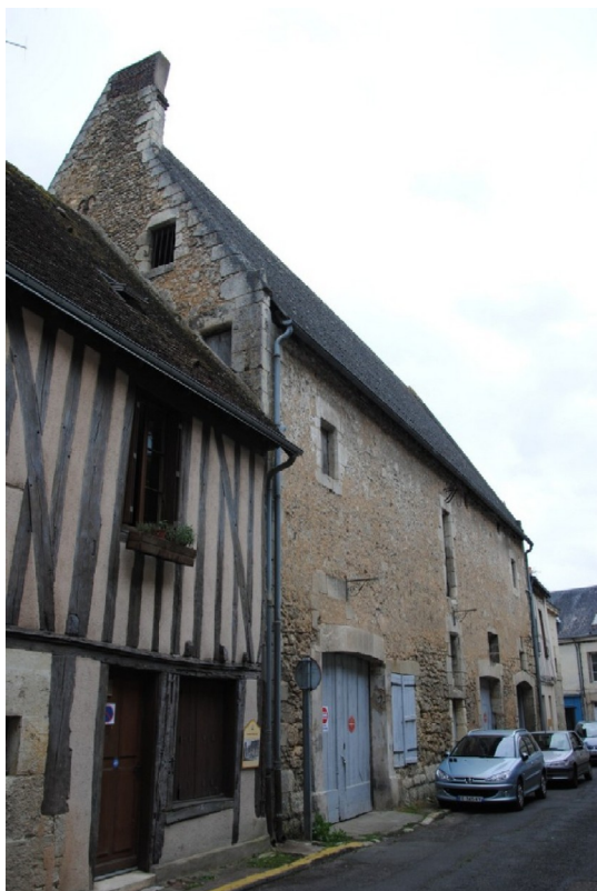
Figure 178 : Ensemble bâti 1024, Vue du mur gouttereau sur rue du grenier à sel
