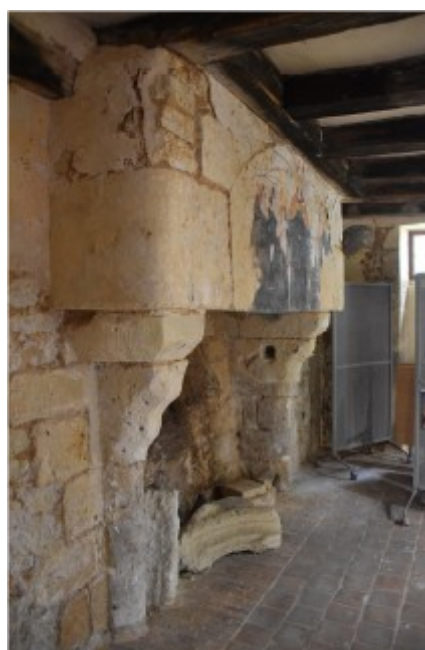
Figure 188 : Ensemble bâti 1007A, La cheminée du rez-de-chaussée avec peintures
