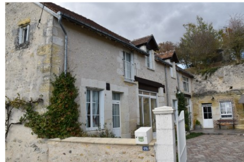
Figure 160 : Ensemble bâti 0821, Le mur gouttereau est du logis
