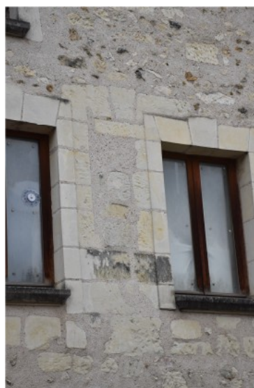
Figure 214 : Ensemble bâti 2032, Détail de la baie bouchée
