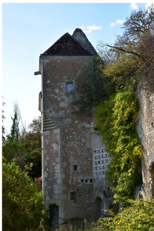
Figure 157 : Ensemble bâti 0816, Vue du manoir depuis l'Est
