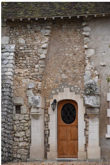
Figure 85 : Cheminée Allée d'Asnières à Lunay (corpus0831)
