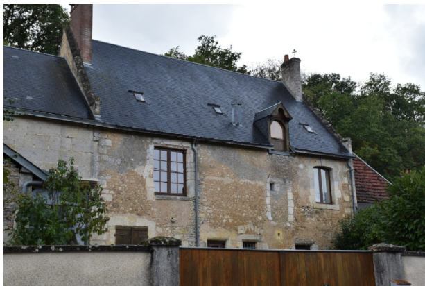
Figure 111 : Maison du 15 e siècle rue du Gondre à Saint-Rimay (corpus 1500)
