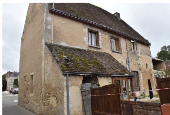
Figure 172 : Ensemble bâti 0802, Vue générale du bâtiment depuis le Nord
