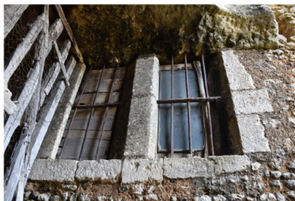
Figure 208 : Ensemble bâti 1900, Détail de la baie à meneau central
