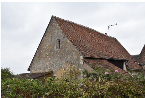
Figure 132 : Grange rue du Puits qui parle à Trôo (corpus 2037)
