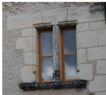
Figure 216 : Ensemble bâti 2013, Baie à meneau central de l'étage
