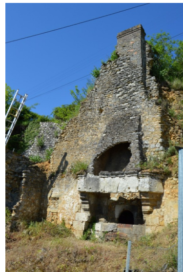
Figure 86 : Cheminée à Nonais à Lunay (corpus0801)
