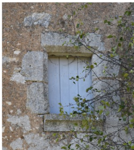
Figure 156 : Ensemble bâti 0816, Baie de la tourelle d'escalier
