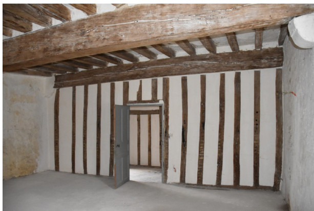
Figure 40 : Prieuré de Lunay : Cloisons en pans de bois à l'étage du bâtiment Est et sommiers reposant sur des corbeaux en quart de rond
