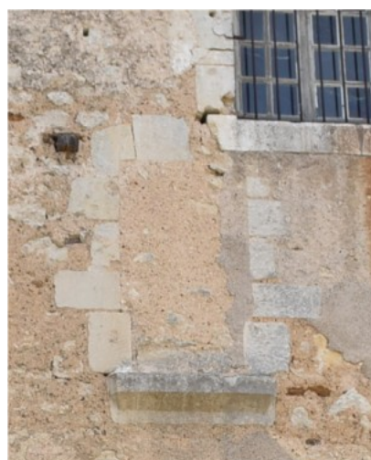
Figure 192 : Ensemble bâti 1007B, Baie à appui chanfreiné de l'étage
