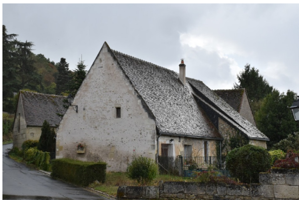
Figure 138 : Maison à pignon chemin des Pins à Villavard (corpus 2100)
