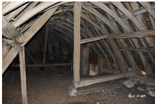
Figure 45 : Prieuré de Lunay : Charpente à chevrons formant ferme du bâtiment Est
