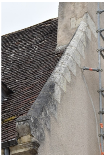
Figure 21: Exemple d'un pignon aux rampants triangulaires (corpus 1043)
