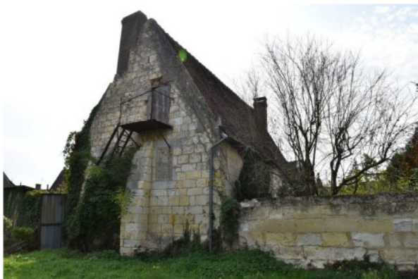
Figure 145 : Ensemble bâti 0100, Vue du bâtiment depuis le Nord
