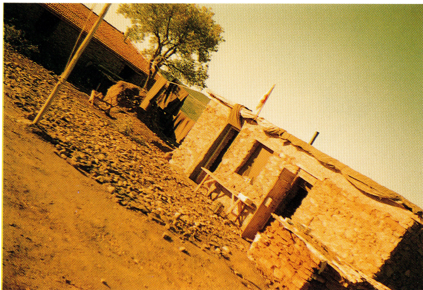
Photo 12.— Piton 636: début des travaux à l'arrivée.
