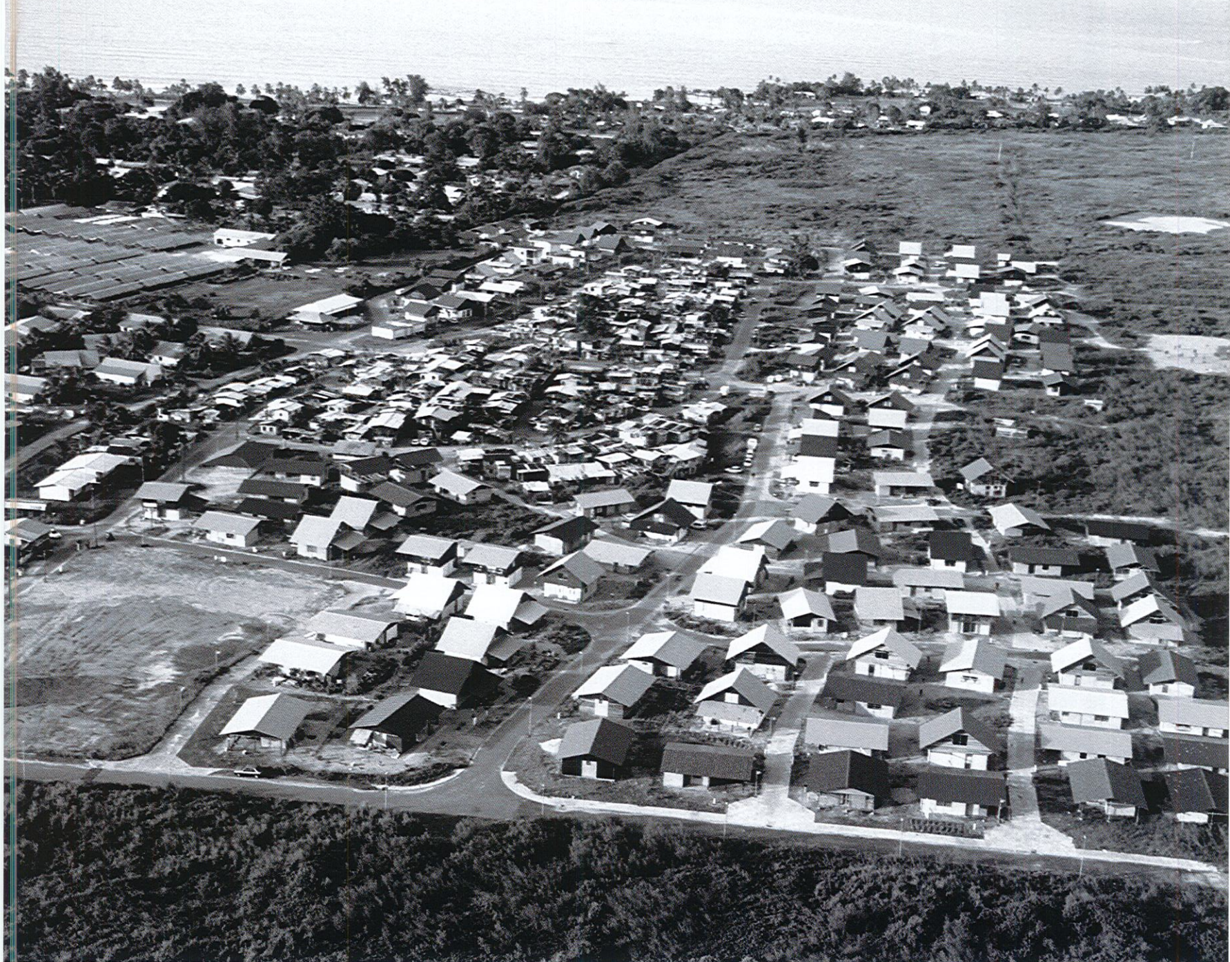
Programme de résorption de l'habitat insalubre du Village Saramaka de Kourou en 1988 par la Société Immobilière de Kourou.
