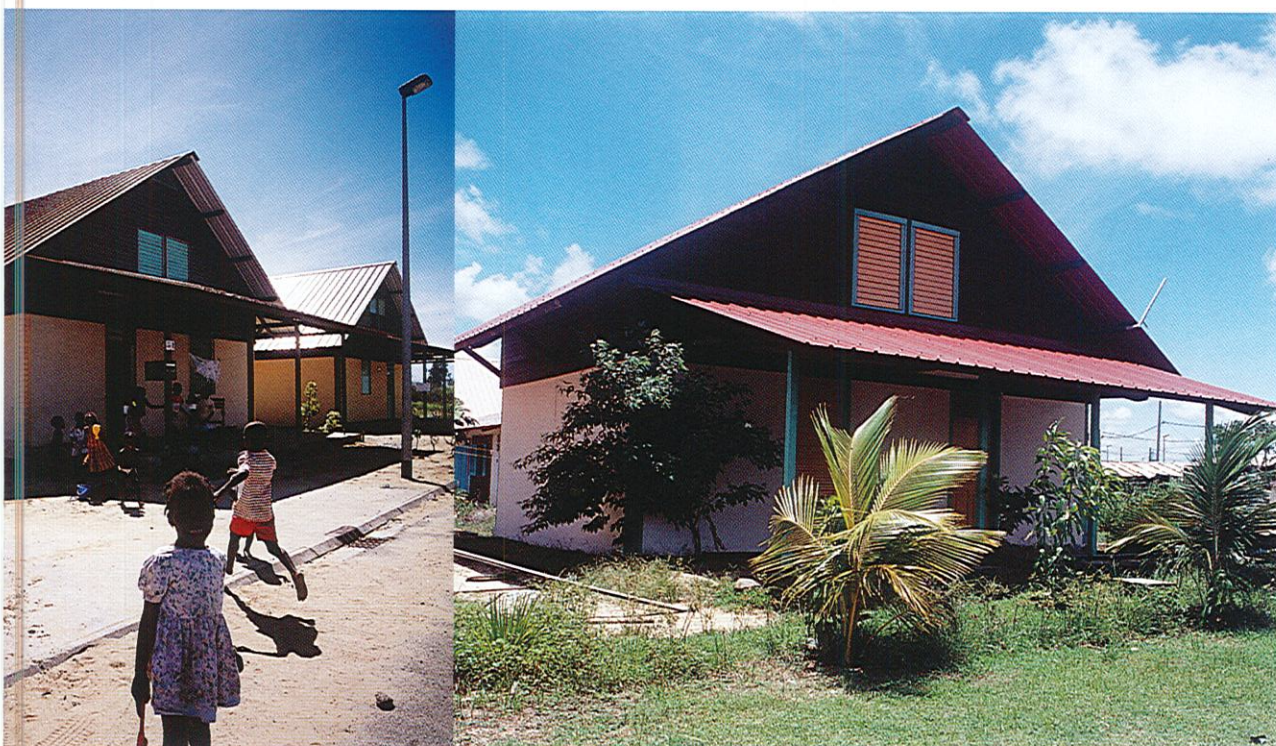
Nouvelles maisons du village.
