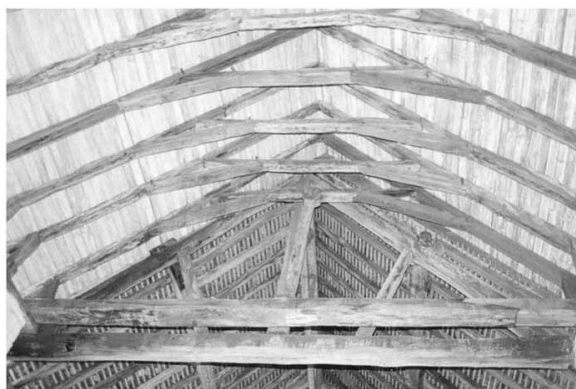
Fig. 21 – Assemblages à mi-bois des aisseliers –
