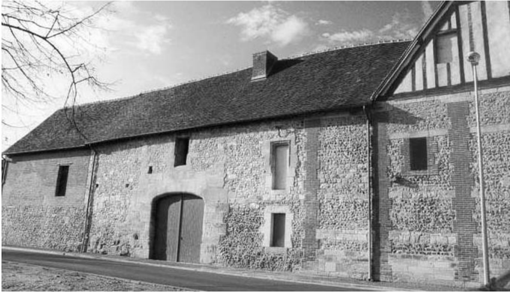
Fig. 6 – Façade de la maladrerie sur la rue du Carmel – (cliché Frédéric Épauld)
