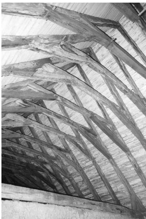
Fig. 20 – Charpente du bâtiment C, fermes secondaires, face nord –
