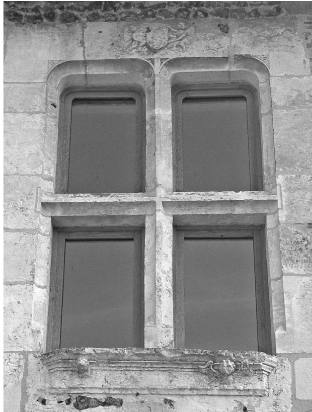
Fig. 8 – La fenêtre de la chambre du prieur –
