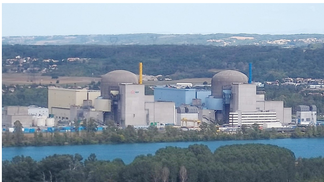
La centrale nucléaire de Saint-Alban
