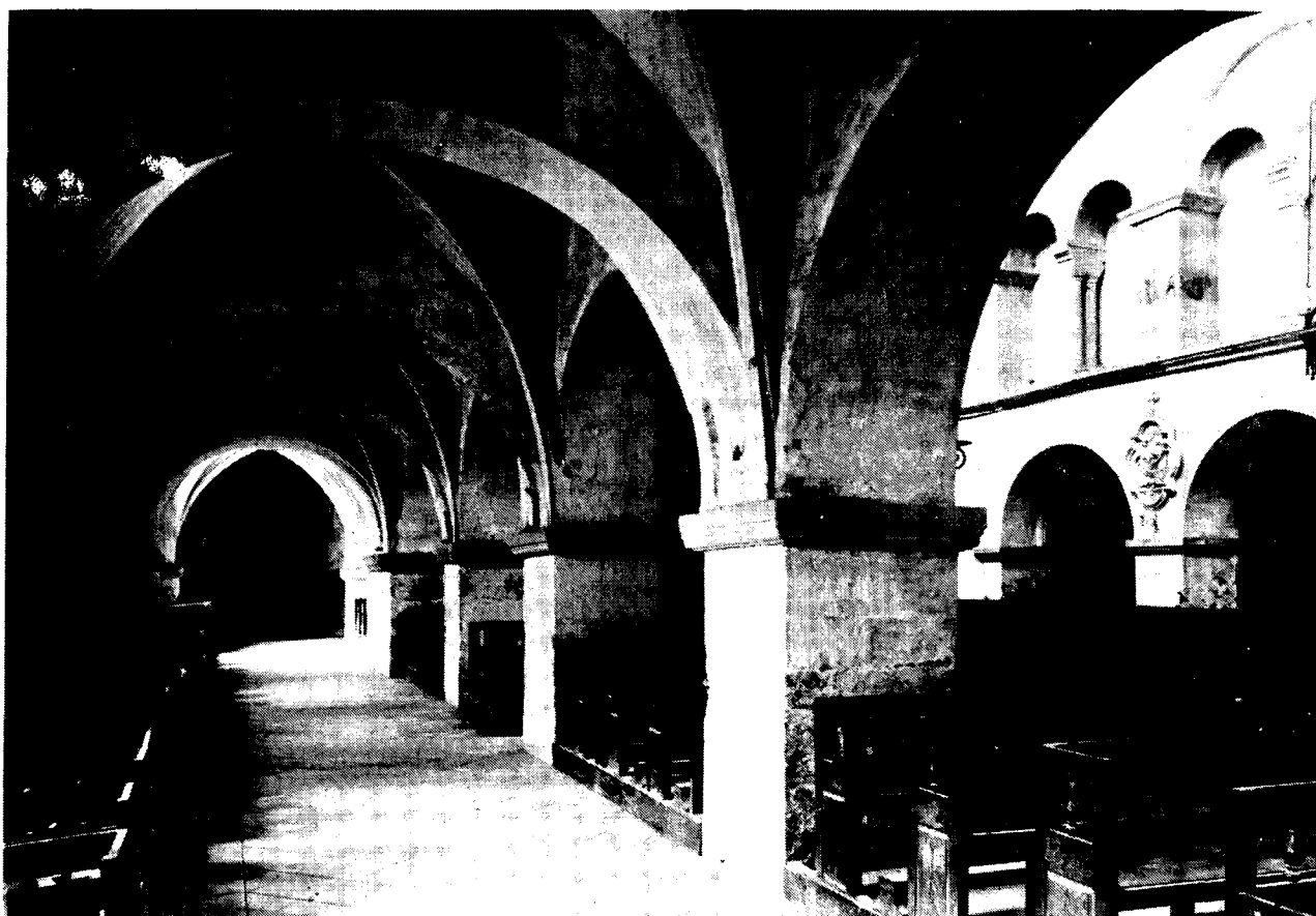
Fig. 6 – Bas-côté sud et nef vus de l'est en 1923 ( Archives des Monuments Historiques ).
