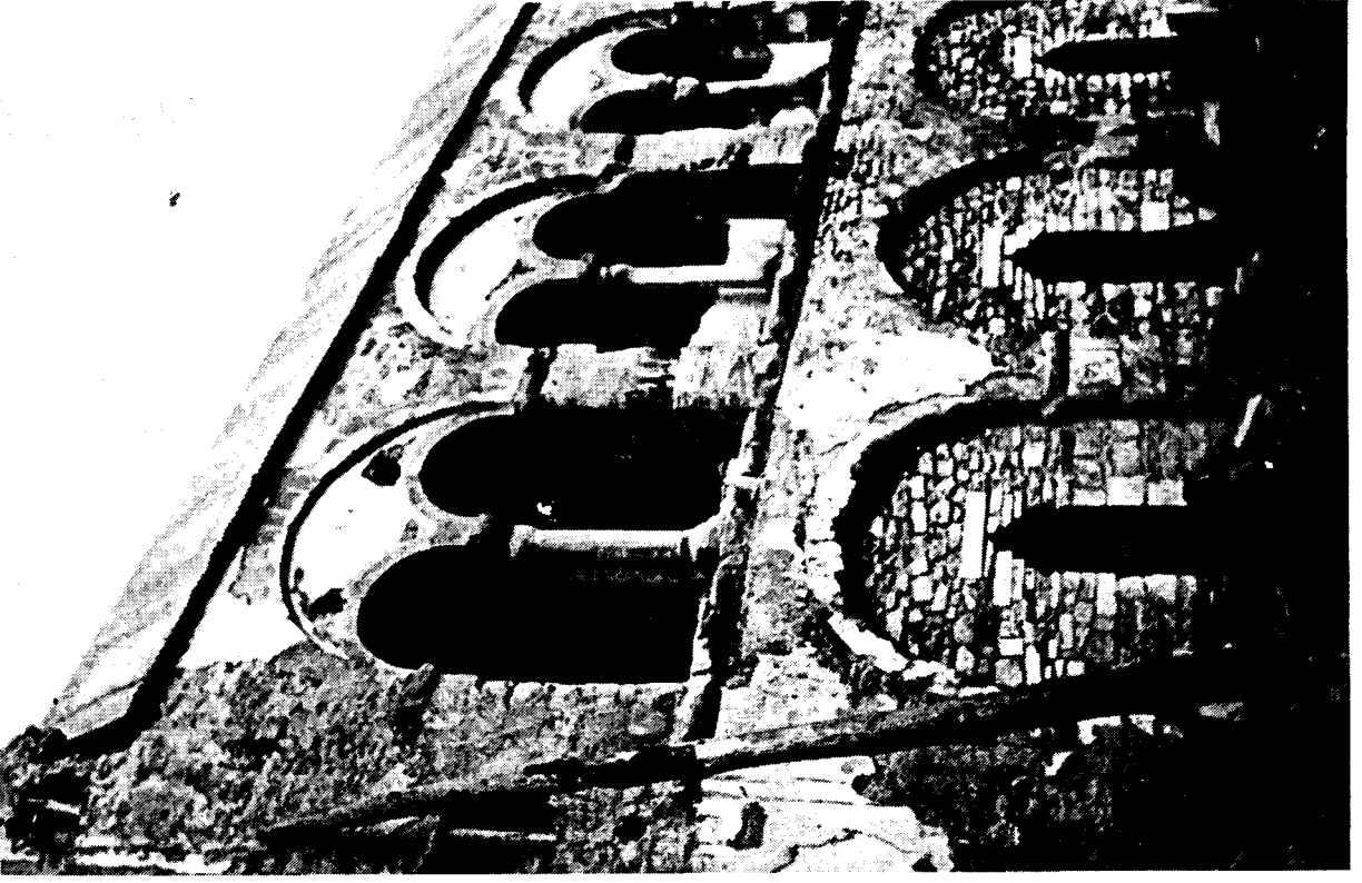
Fig. 3 – Élévation latérale nord de la nef en 1947 : pilier élargi et troisième, quatrième et cinquième travées (Archives privées).
