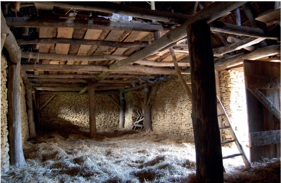
Pl. XIII. Poteaux axiaux de soutien à un plafond constitué d'entrails d'une charpente à chevrons-formant-fermes. Maison expérimentale du x e siècle, archéosite d'Ornavik (14) (Cl. F.E)
