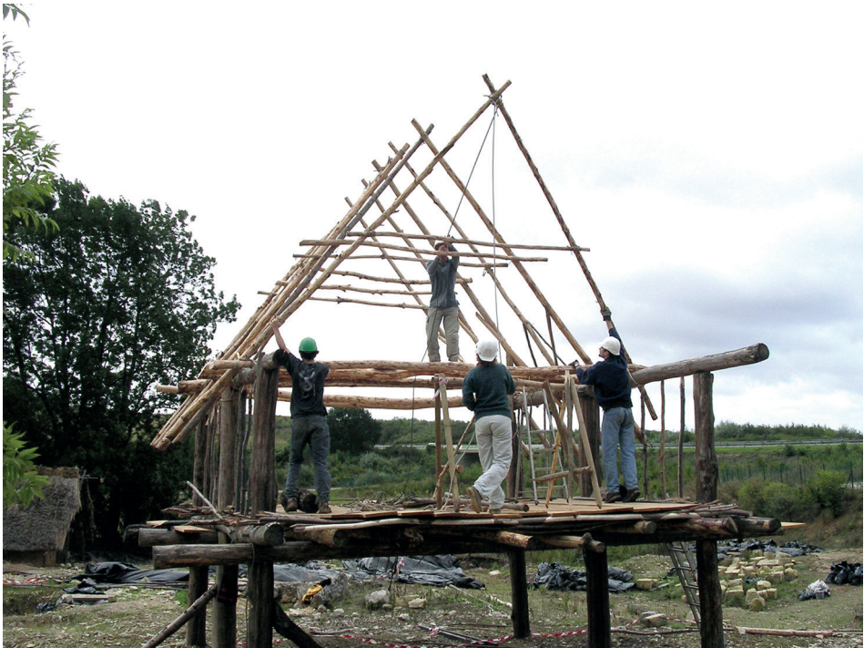
Pl. XI.1. Mise en place d'une faîtière sur une construction expérimentale à poteaux faîtières (Cl. F.E.)
