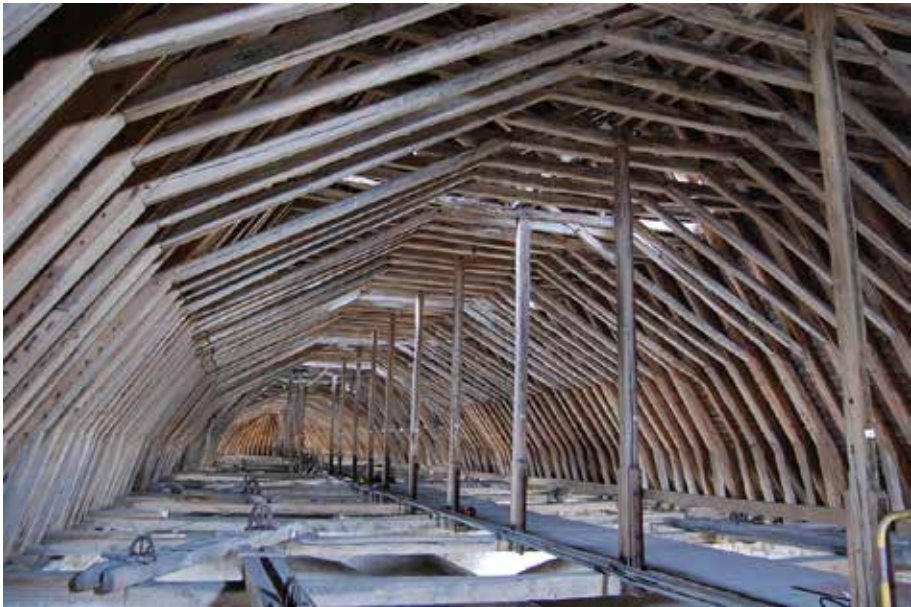
Figure 1 : Charpente de la cathédrale de Bourges mise en œuvre en 1256-1258 avec des bois de brin longs et très fins, équarris à minima (cliché F. Epaud).
