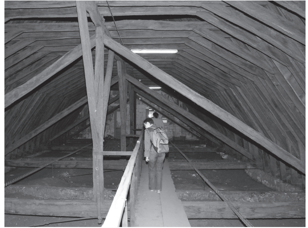
Fig. 9 – Paris, ancien prieuré de Saint-Martin-des-Champs, toiture de l'ancien Réfectoire, début 1215-1220d (Hoffsummer, 2002). Photo : P. Hoffsummer.
