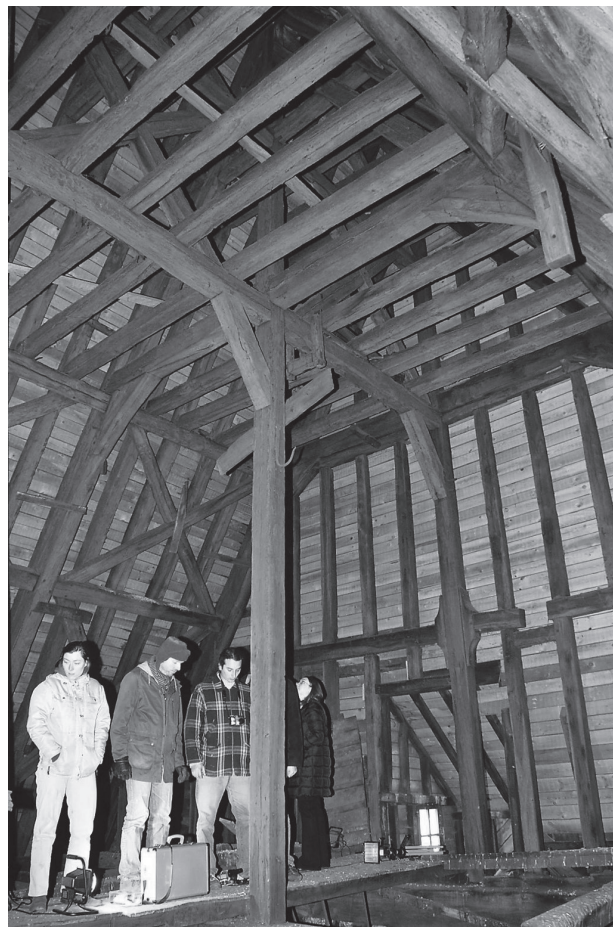
Fig. 13 – Liège (B.), église Saint-Denis, toiture du chœur avec sa fermeture provisoise (1422-1423d). Photo : P. Hoffsummer ULG-CEA.
