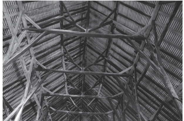
Fig. 14 – Vermenton (Yonne), église Notre-Dame, charpente du chœur (1300-1314d) construit en édifice halle à trois nefs. Hoffsummer, Lambert, Weitz 2012. Photo : P. Hoffsummer ULG-CEA.
