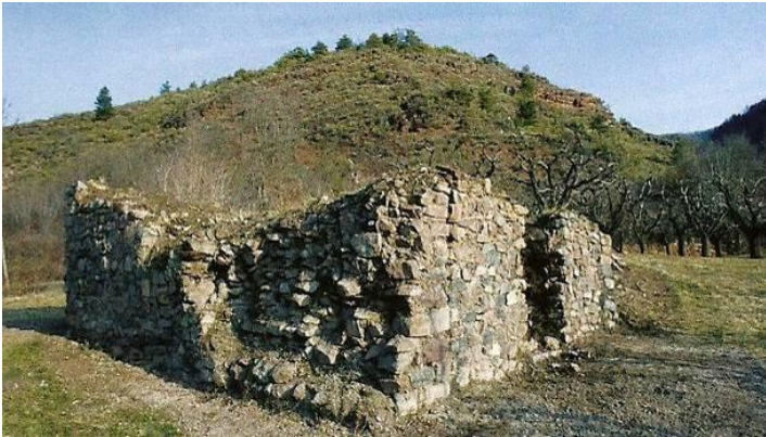
Figure 7 : Le même édifice libre de végétation
