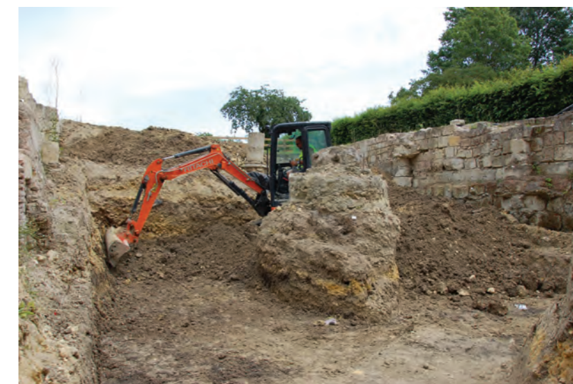
d. Enlèvement des remblais, vue depuis l'ouest.
