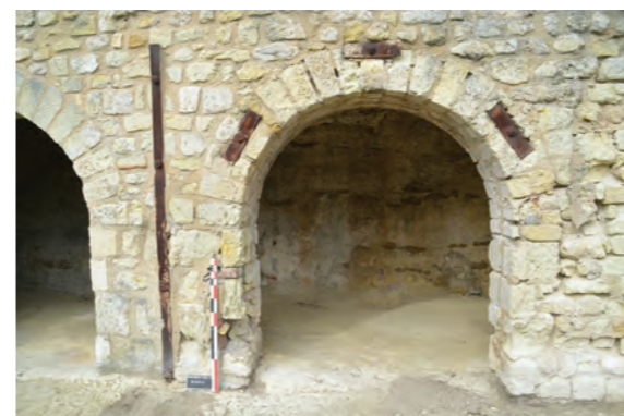
ARC 2568 vu depuis le sud
