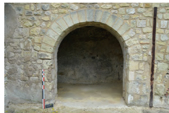
ARC 2567 vu depuis le sud
