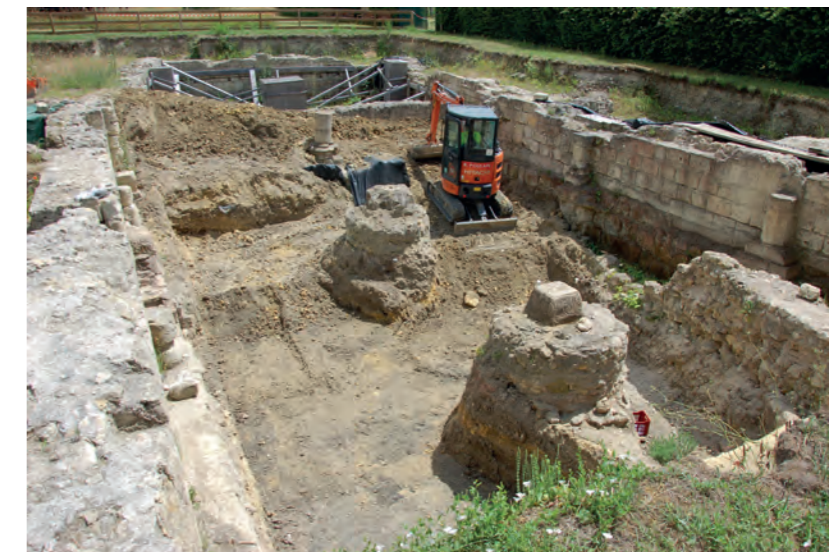
c. Enlèvement des remblais en cours et fabrication de la «rampe», vue depuis le nord ouest.
